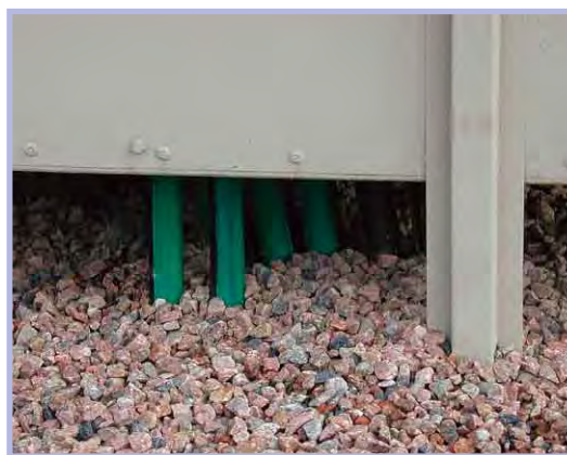
Bild 6 Det färdiga resultatet med oskyddad optofiber under en teknikbod
