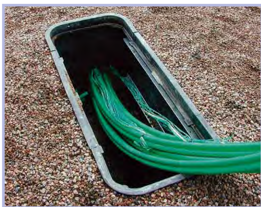
Bild 5 Optofiber under utbyggnad
