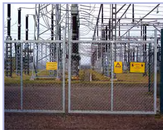
Bild 4 Bilden visar en godkänd grind för drifttrum
