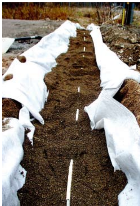
Förläggning av sensorkabel.
