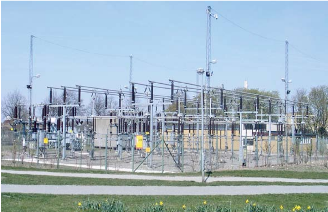
Anläggning med utbyggt områdesskydd i stadsmiljö.
