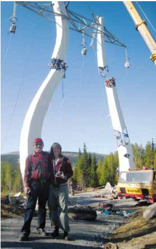
Stolpen håller på att resas den 14 september 2009. Konstnären Anna Cronheden och fastighetsägaren Jöns-Erik Andersson - vars mark stolpen står på - är lyckliga över att stolpen äntligen kommit på plats. Arbetet med att resa stolpen tog en dag. Foto: Katrin Seuss.
