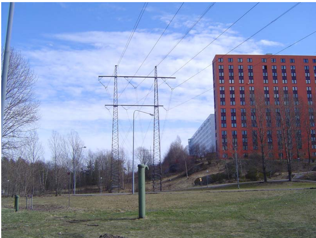
Sambyggda 220 kV och 70 kV ledningar vid Flemingsbergs centrum
