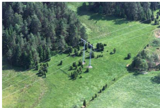
Ledning för 220 kV mellan Nässjö och Värnamo.
