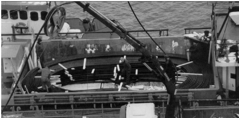
Figur 5-2 Lastning ("coilning") av sjökabel på fartyg.
