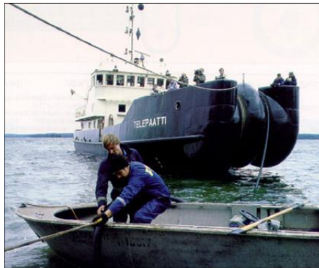
Figur 5-1 Bilden till vänster visar landtagning av kabel i sjökabeldike. Bilden till höger visar förläggning av sjökabel från fartyg.
