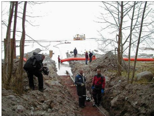
Figur 5-1 Bilden till vänster visar landtagning av kabel i sjökabeldike. Bilden till höger visar förläggning av sjökabel från fartyg.
