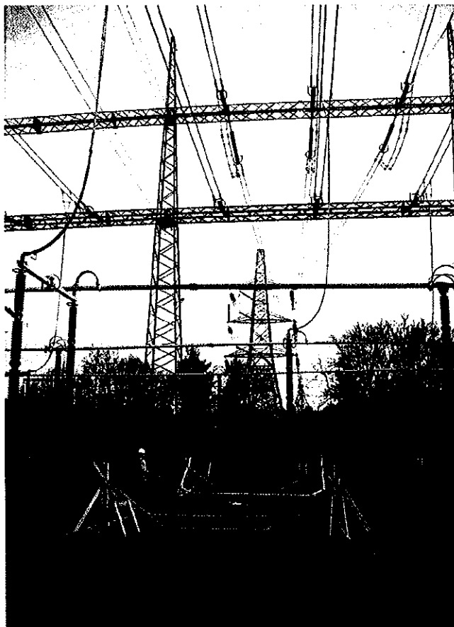
Bild 7.5: Stommen nedfälld. Placerad rakt under A-skenans R-fas och mellan S-och R-fasen på inkommande kraftledning 3.
