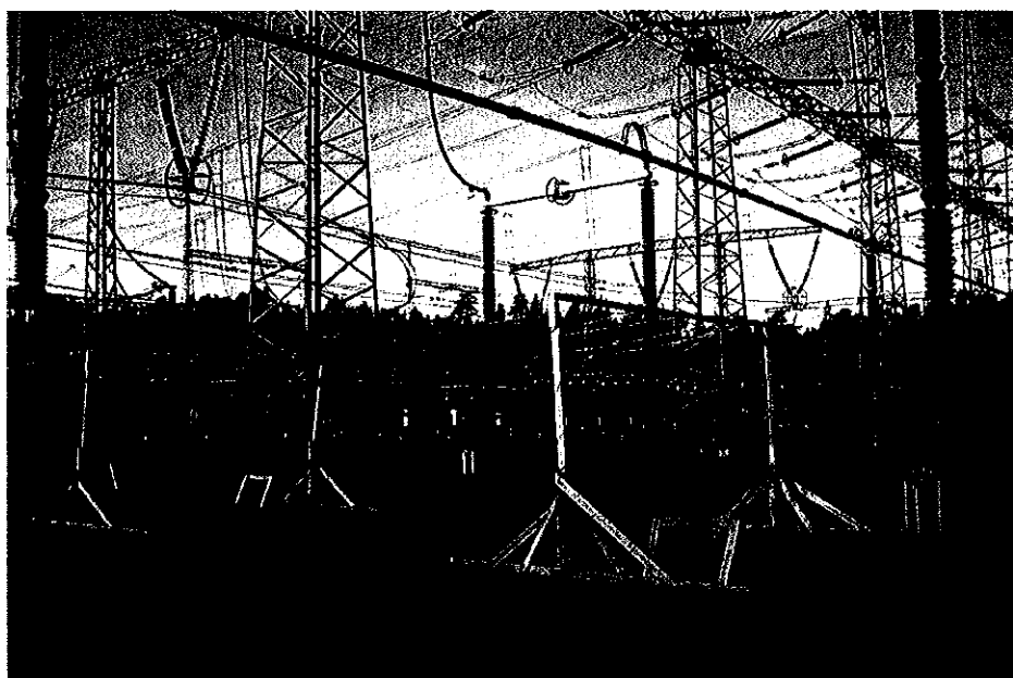
Bild 7.4: Stommen uppfälld med skärmlinor, inne i ställverket
