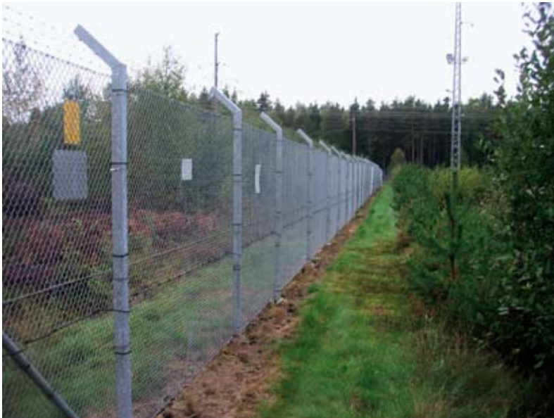
Stängsellarm med mikrofonskabel
