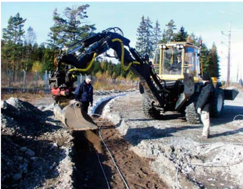
Förläggning av marklarm
