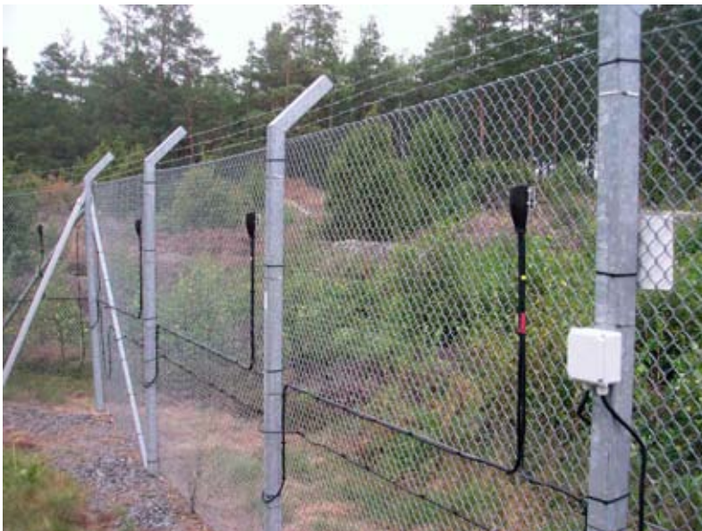
Vibrationsdetektorer monterade på stängsel
