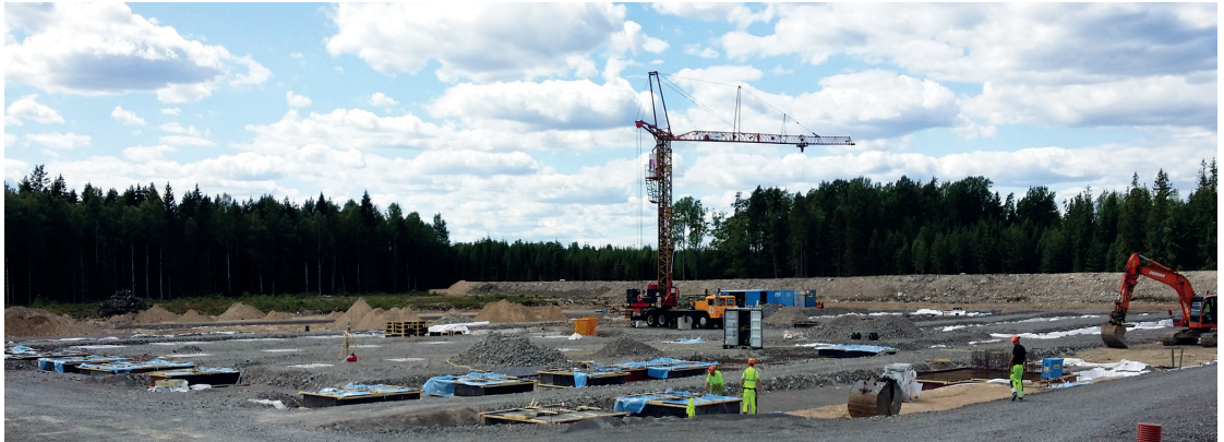
På detta område, intill det nya ställverket, kommer omriktarstationen att växa fram under det kommande året.
