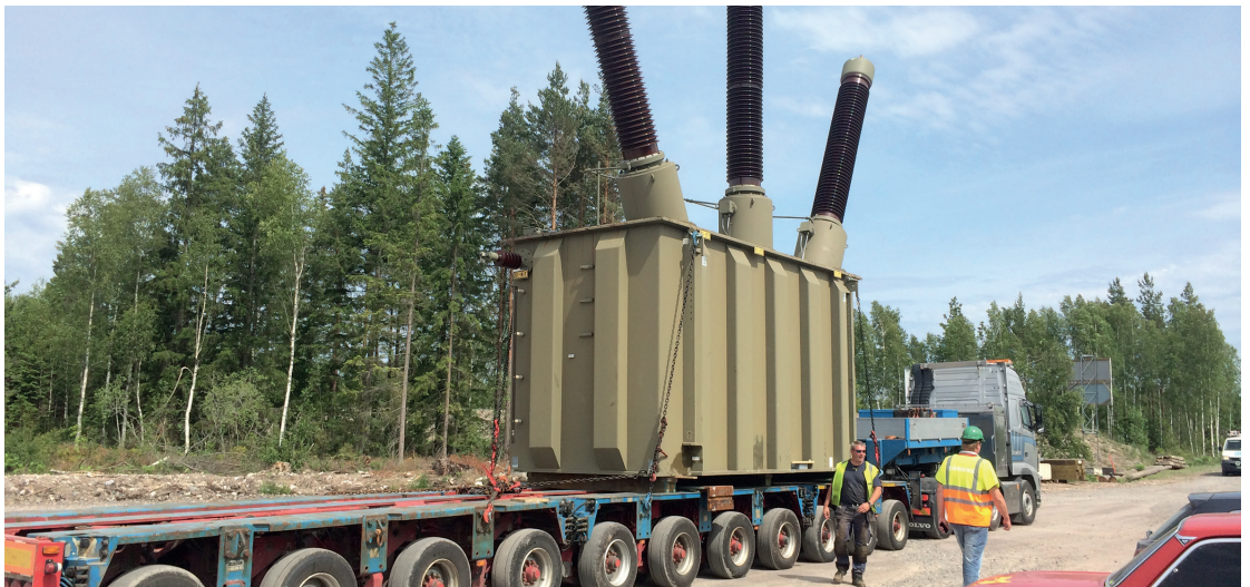
Reaktorn på flaket väger 13 ton och flyttades här från det gamla till det nya ställverket i Nybro station.
