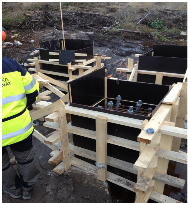
Figur 25 Fotografi av betongfundament som gjuts på plats.
