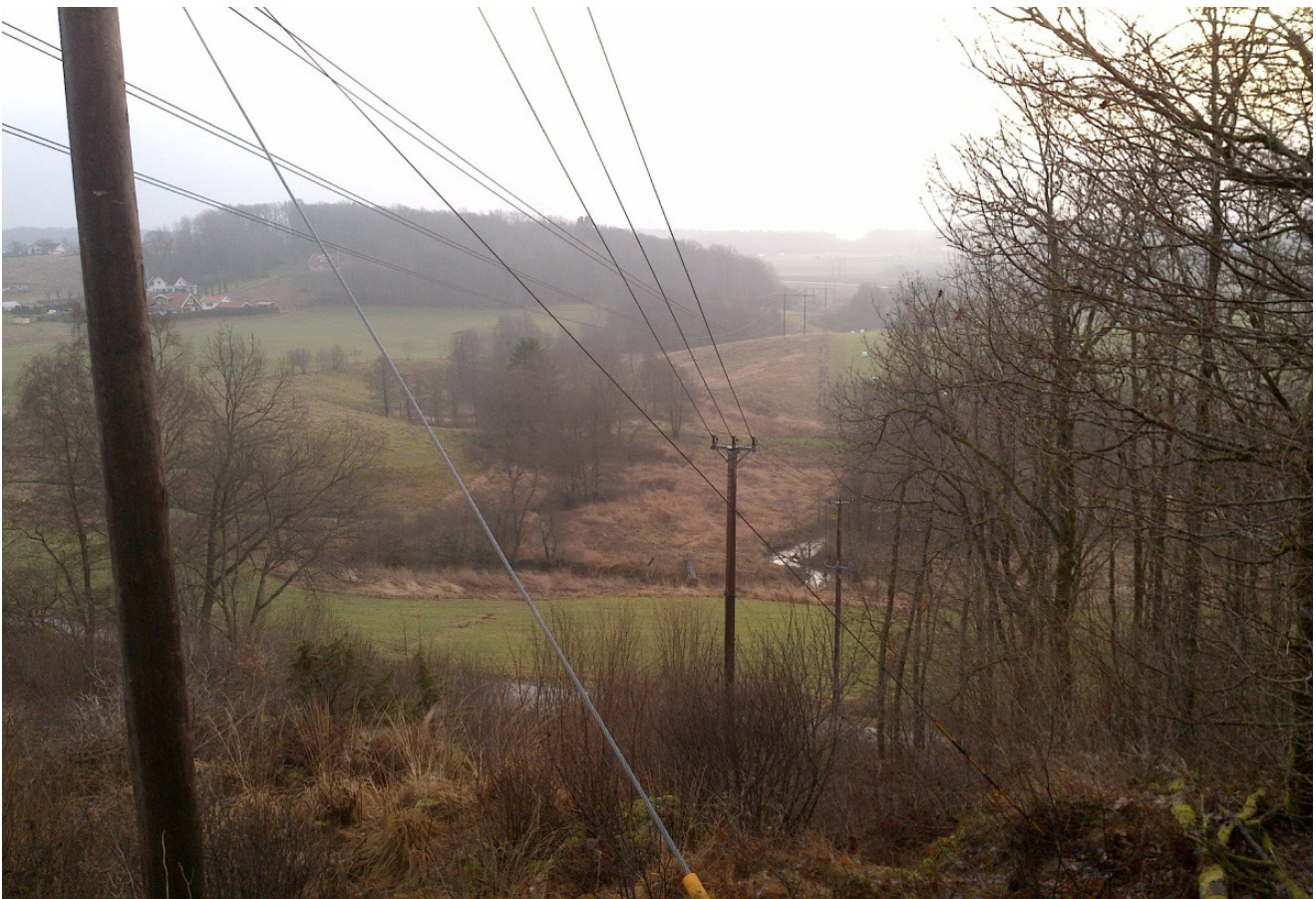
Figur 44. Ädellövskog öster om Alafors (NVI_50). Ledningen parallellförläggas med befintlig 130 kV-ledningen, på dess norra sida, och kommer därmed inte medföra någon påverkan på objektets naturvärden.
