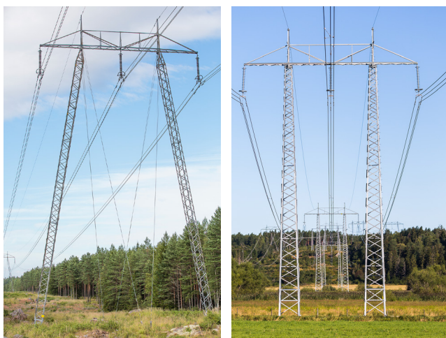
Figur 21 Aktuella stolptyper för planerad 400 kV-ledning. Till vänster en portalstolpe 400 kV typ A, stagad, som i huvudsak används i skogsmark. Till höger en portalstolpe 400 kV typ B, ostagad, som i huvudsak används i jordbruksmark. Avståndet mellan ytterfaser är cirka 18-22 meter.
