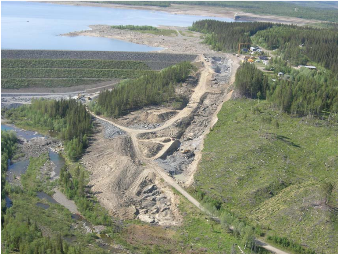
Figur 8. Pågående ombyggnadsarbeten för att förse Häckrendammen med ett nytt utskov och därigenom ytterligare höja säkerheten. (Foto: Vattenregleringsföretagen, 2006)
