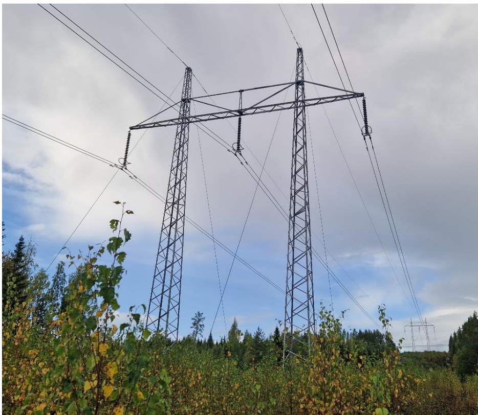
Figur 3. Befintliga stagade portalstolpar av aktuell ledning.
