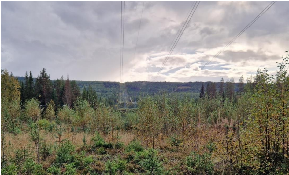
Figur 4. Aktuell ledning genom ett större skogslandskap strax norr om Ammerån vid Selet.
