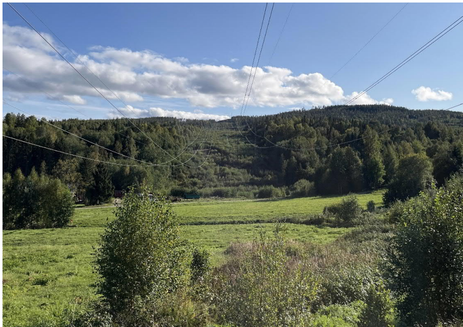
Figur 11. Befintlig och planerad ledningsgata genom skogsmark i höjd med Norrlindsjö.
