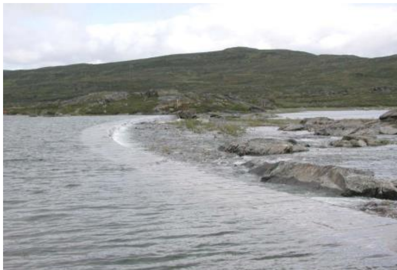
Figur 15: Överrinning i Sitasjaure vid Ritsem vattenkraftverk. Betongklacken är synlig strax under vattenytan. Källa: [36]
