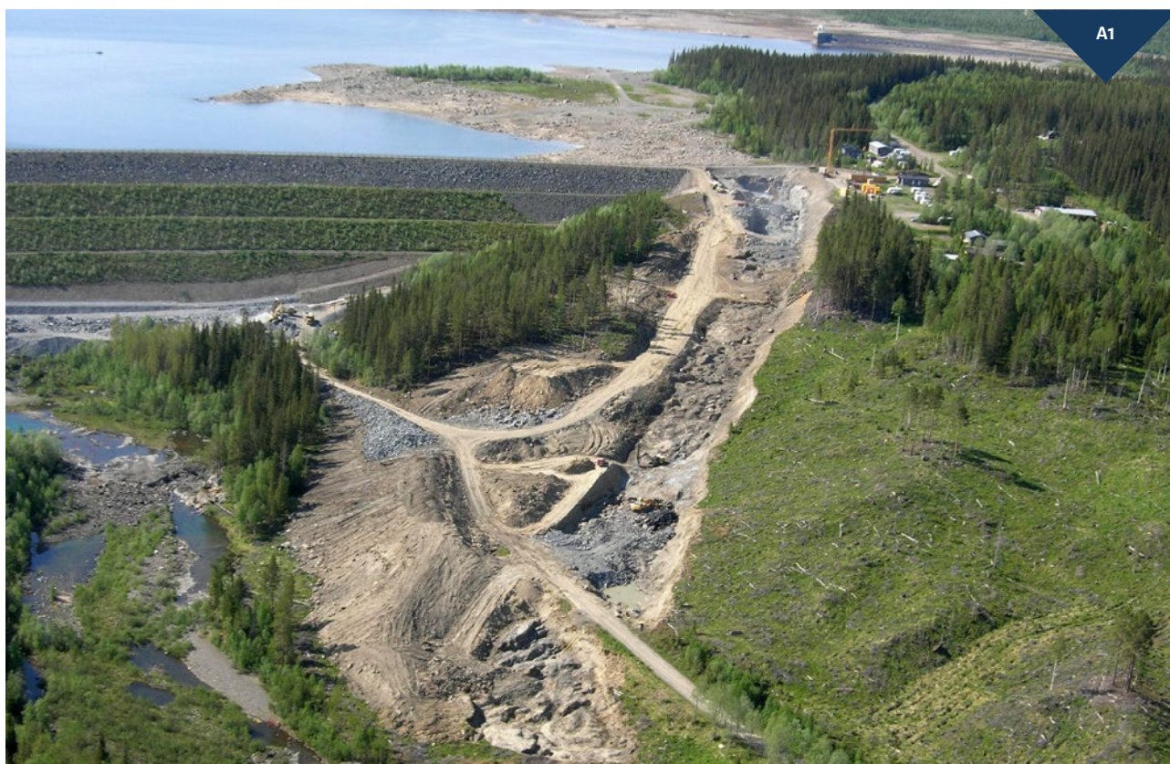
Construction work to provide the Håckren dam with a new surface spillway. Photo: Vattenregleringsföretagen, 2006.
