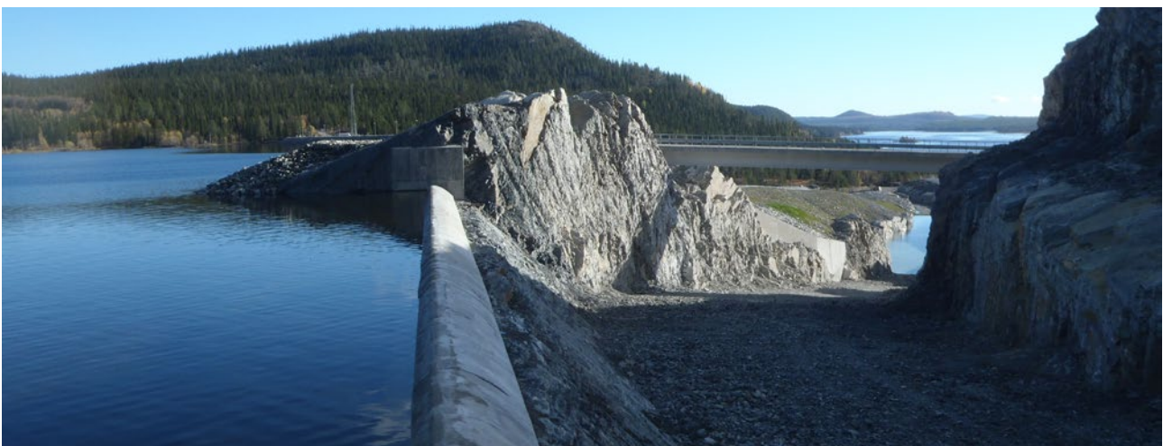
New spillway at Dabbsjö dam. Photo: Peder Lönneborg.
