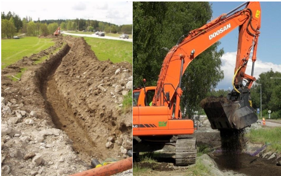
Figur 13. Exempel på markkabeldike och återfyllning med siktskopa.
