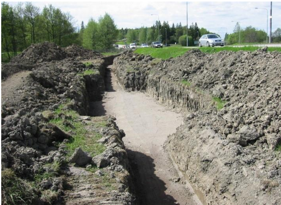
Figur 11. Exempel på skarvgrop för högspänningskabel.
