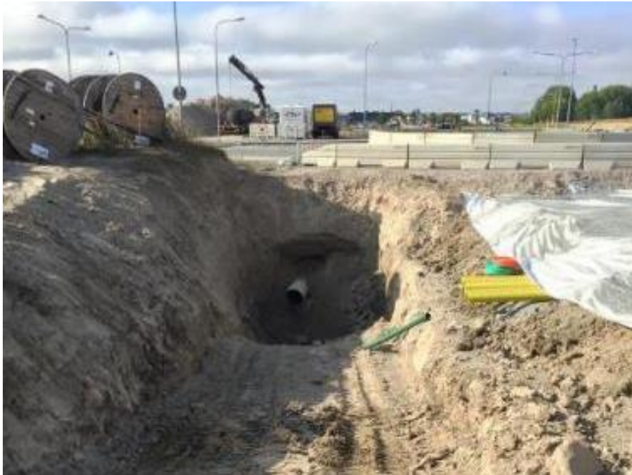
Figur 14. Hammarborrning för passage av markkabel under en väg.
