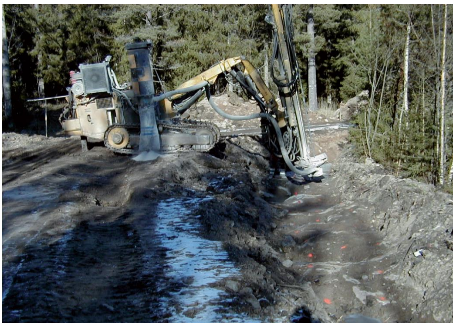
Figur 15. Borrning inför sprängning av berg i markkabelschakt.
