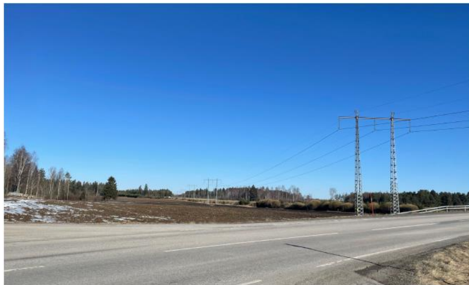
Figur 17. Befintlig och planerad ledningsgata genom växelvisa jordbruksmarker vid Torkelsbo i anslutning till E4:an.
