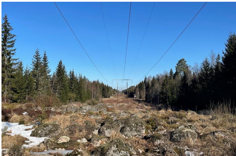
Figur 22. Befintlig och planerad ledningsgata i blockrik skog i anslutning till Yttröskogens naturreservat, vy mot norr.
