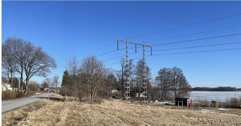
Figur 30. Befintlig 220 kV-ledning längs Långsjön i Björklinge som kommer att kunna avvecklas i samband med etablering.
