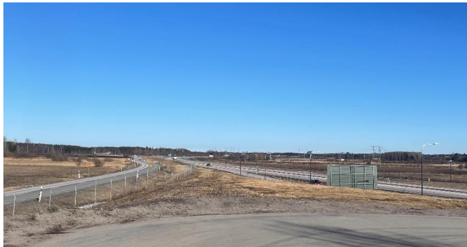
Figur 32. Befintliga 220 kV-ledningar i anslutning till E4:an väster om Tierp, vy mot norr. Utbyggnadsförslaget planeras väster om E4:an.
