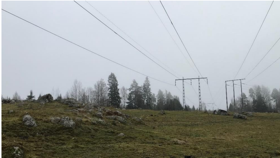
Figur 25. Stensättning L1942:5460 i anslutning till befintlig och planerad ledningsgata i en beteshage söder om Tämnarån.
