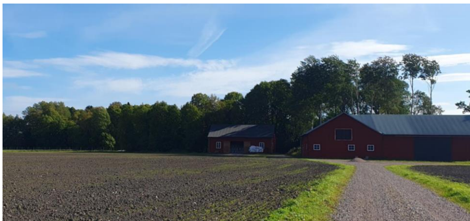
Figur 13. Magasinsbyggnader vid Sommaränge som planeras att rivas till följd av utbyggnadsförslaget.
