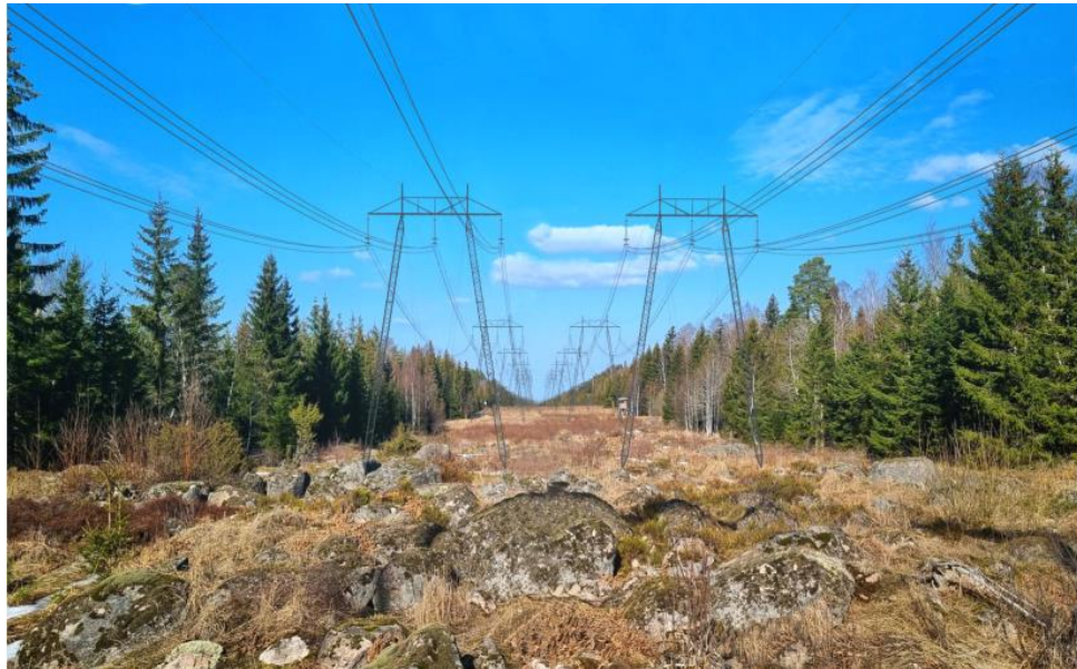
Figur 18. Fotomontage av planerade parallellbyggda portalstolpar vid passage längs befintlig och planerad ledningsgata i skogsmark.
