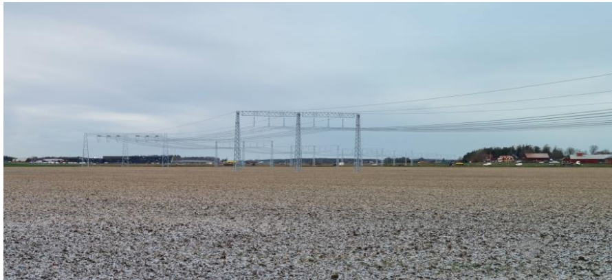
Figur 8. Fotomontage över sambyggd portalstolpe för 2x400 kV.
