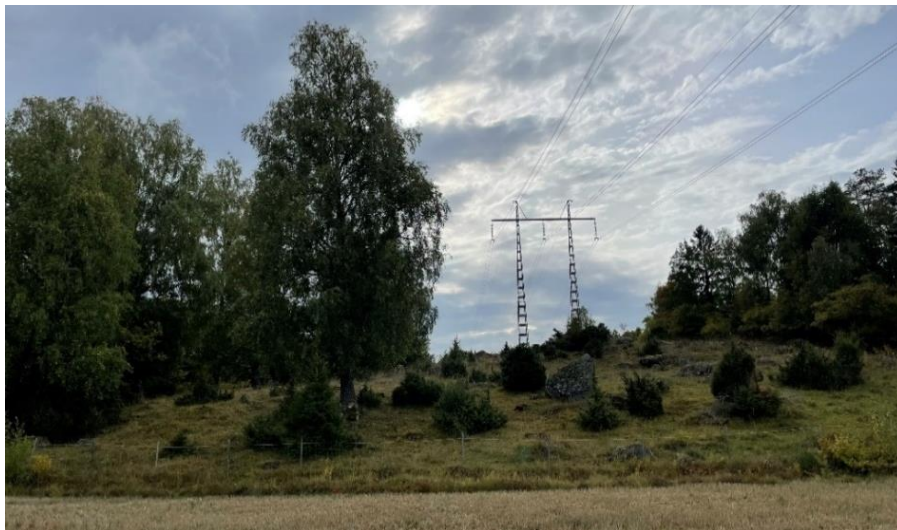
Figur 21. Vy mot söder över naturvärdesobjekt ID45 i anslutning till befintlig och planerad ledningsgata.
