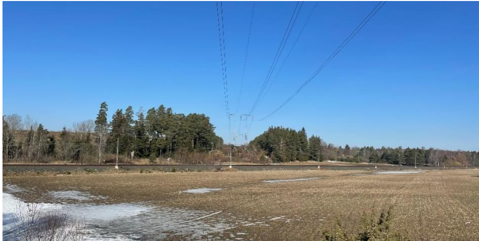
Figur 33. Befintlig 220 kV-ledning och planerad ledningsgata som korsar Ostkustbanan vid Fullerö, Storvreta.
