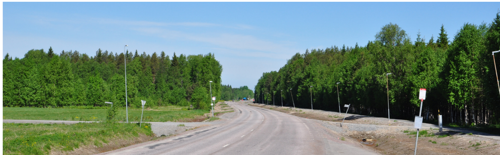
Figur 10. Ledningarna planeras korsa väg 969 norr om Luleå i skogsmarken i bakgrunden av fotot. I närheten återstår delar av den tidigare öppna odlingsmarken mellan Rutvikssund och Reveln.
