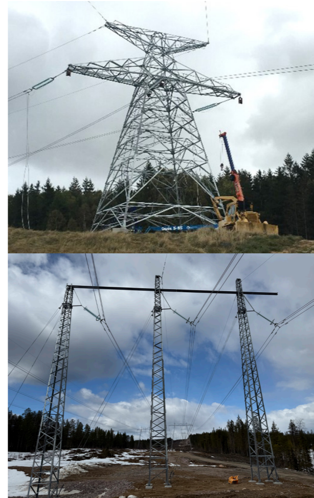
Figur 5. Exempel på olika typer av vinkelstolpar.
