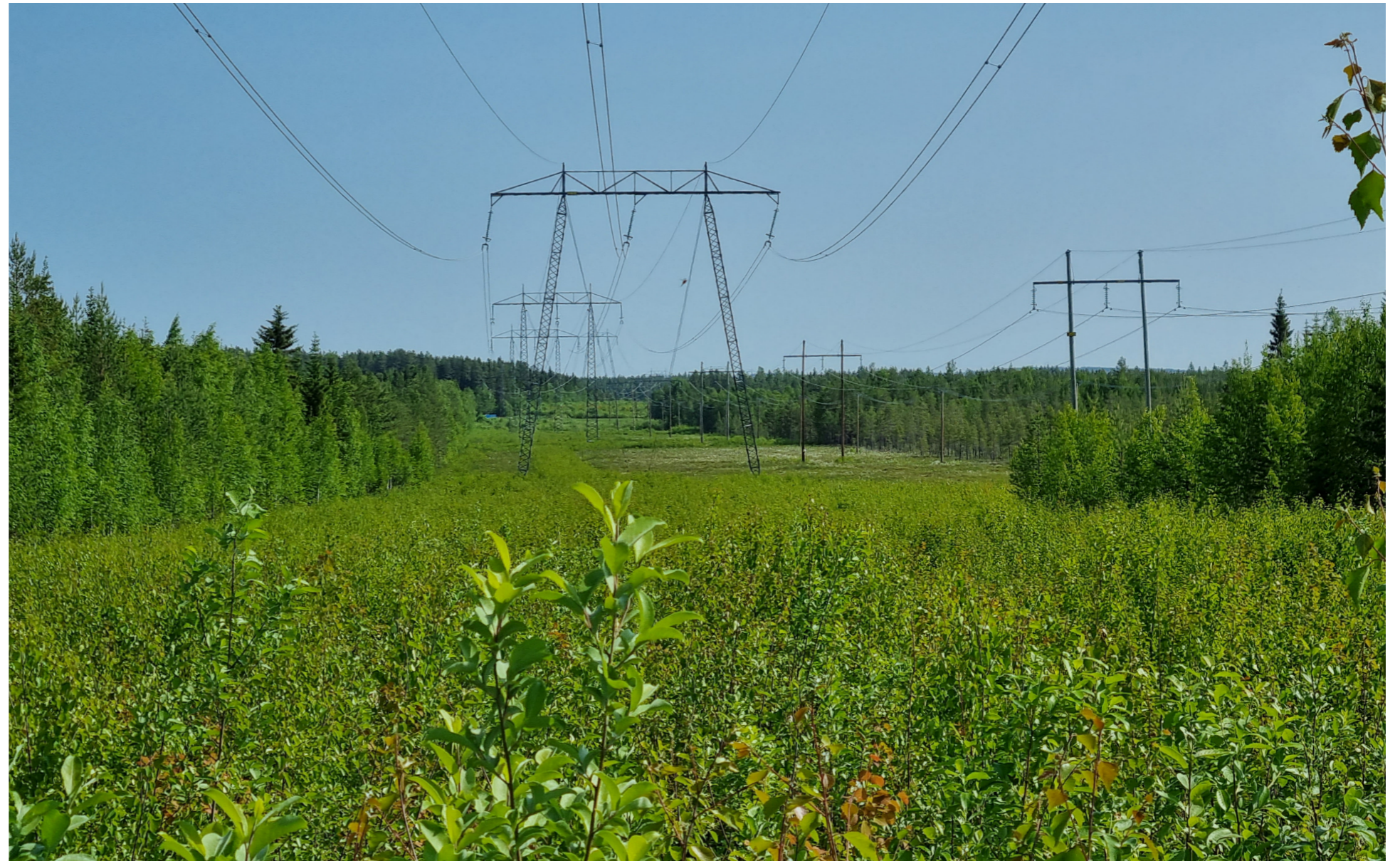
Figur 3. Befintlig 400 kV-ledning nära Svartbyn i Bodens kommun. Fotot ger exempel på en A-stolpe i förgrunden och B-stolpar bakom denna. Foto mot nordöst.
