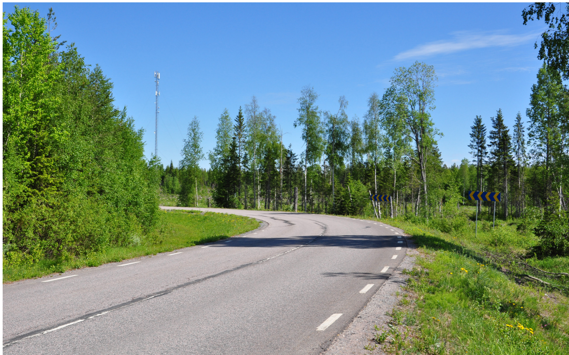
Figur 26. Platsen där de planerade ledningssträckarna korsar väg 968. Foto från sydväst.
