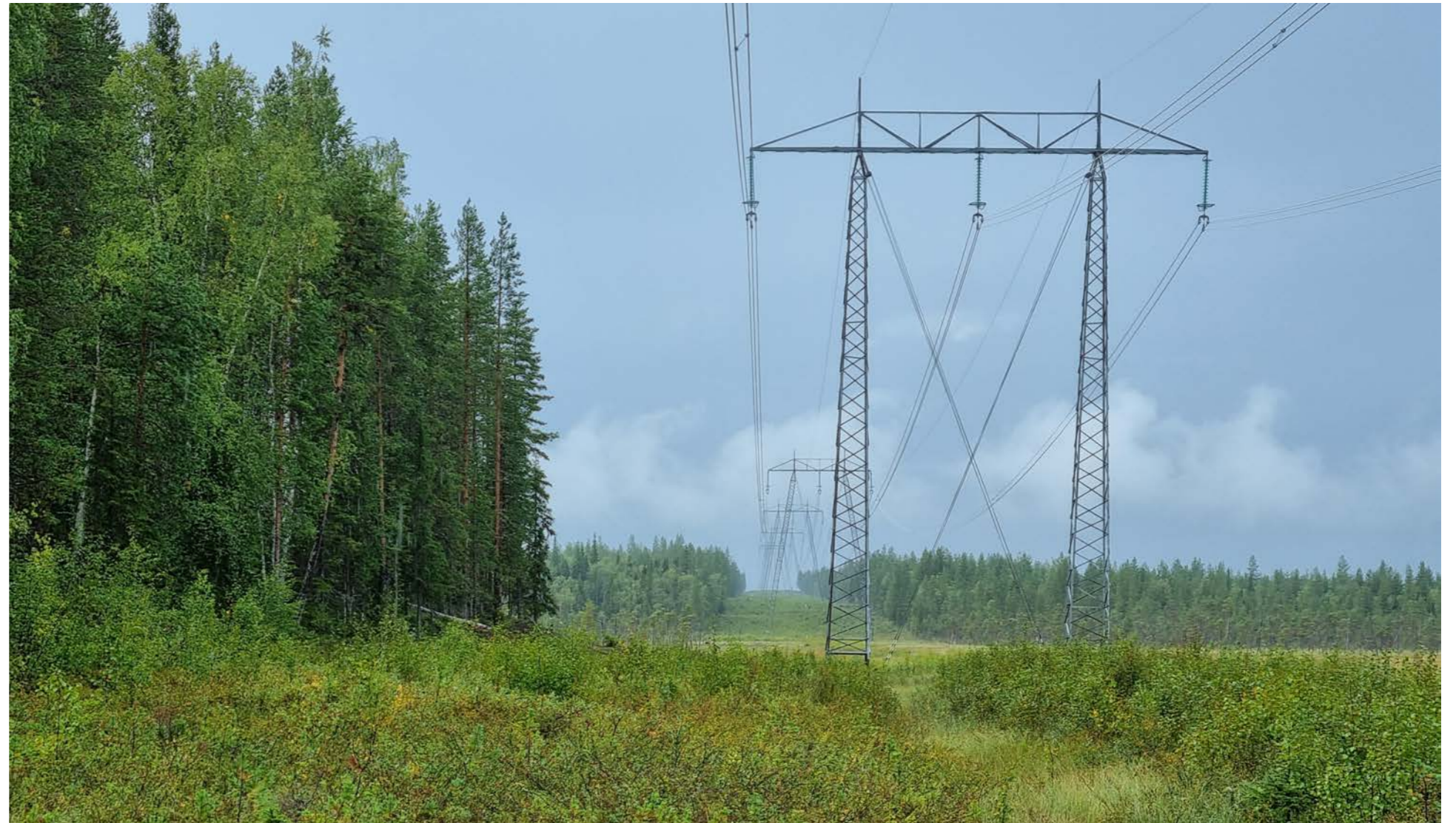
Figur 3. Befintlig 400 kV-ledning nära Grundträsket i norra Bodens kommun. Den nya ledningen placeras parallellt med och till vänster om denna sett i bildens riktning och får ett likartat utseende. Fotot ger exempel på en B-stolpe på myrmarken i förgrunden och A-stolpar i skogsmarken i bakgrunden. Foto mot nordväst.
