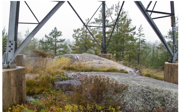
Figur 5.5a Fundamenten och nederdelen av en julgransstolpe i befintlig ledning som ett exempel på hur det kan komma att se ut i utbyggnadsförslaget.
