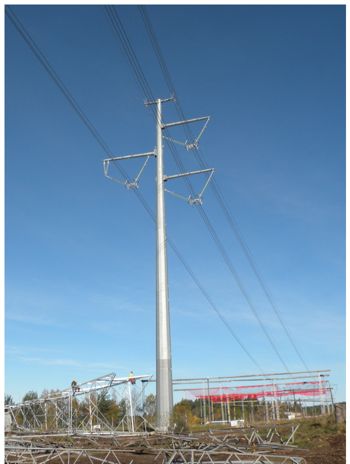
Figur 5.3 Exempel på en rörstolpe av stål. I denna stolpe hänger en ledning som motsvarar Svenska kraftnäts planerade ledning med tre s.k. faser och där varje fas är utförd som triplex (tre ledare per fas). Längst upp i stolpen hänger två topplinor.
