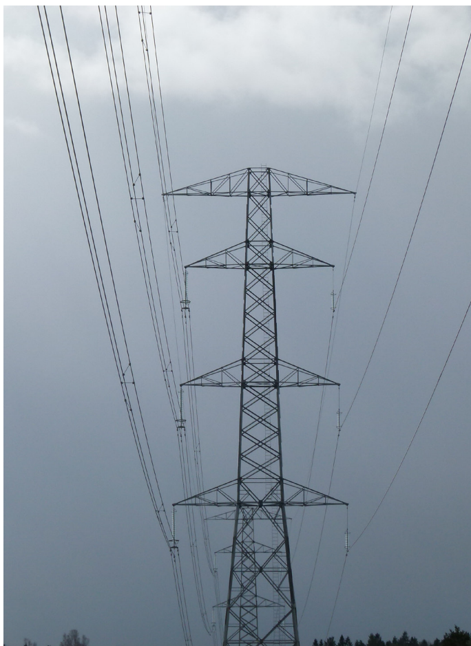
Figur 5.2 Exempel på en julgransstolpe av stål. I denna stolpe hänger två ledningar, en på vänstra och en på högra sidan. På den vänstra sidan hänger en ledning som motsvarar Svenska kraftnäts planerade ledning med tre s.k. faser och där varje fas är utförd som triplex (tre ledare per fas). På den högra sidan hänger en ledning som motsvarar Vattenfalls planerade ledning med tre faser och där varje fas är utförd som simplex (en ledare per fas). Högst upp på varje sida hänger en topplina.
