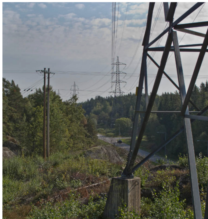
Figur 7.2a. Ledningen syns väl där den korsar Ågestavägen.
