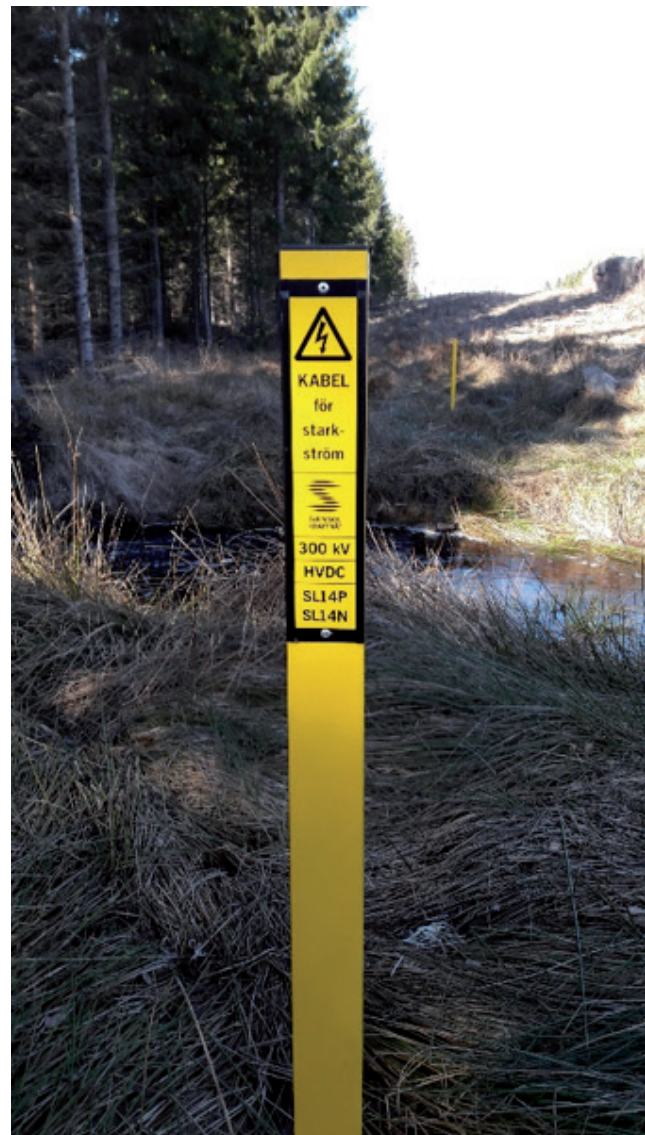
Figur 4.6. Kabelmarkeringsstolpe.
