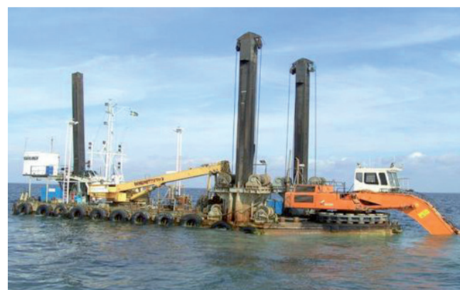
Figur 4.16 Exempel på grävmaskin på en pråm.
