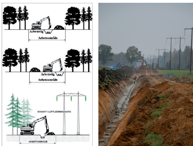
Figur 4.4 Arbetsområde (t.v.). Kabeldikesschakt (t.h.).
