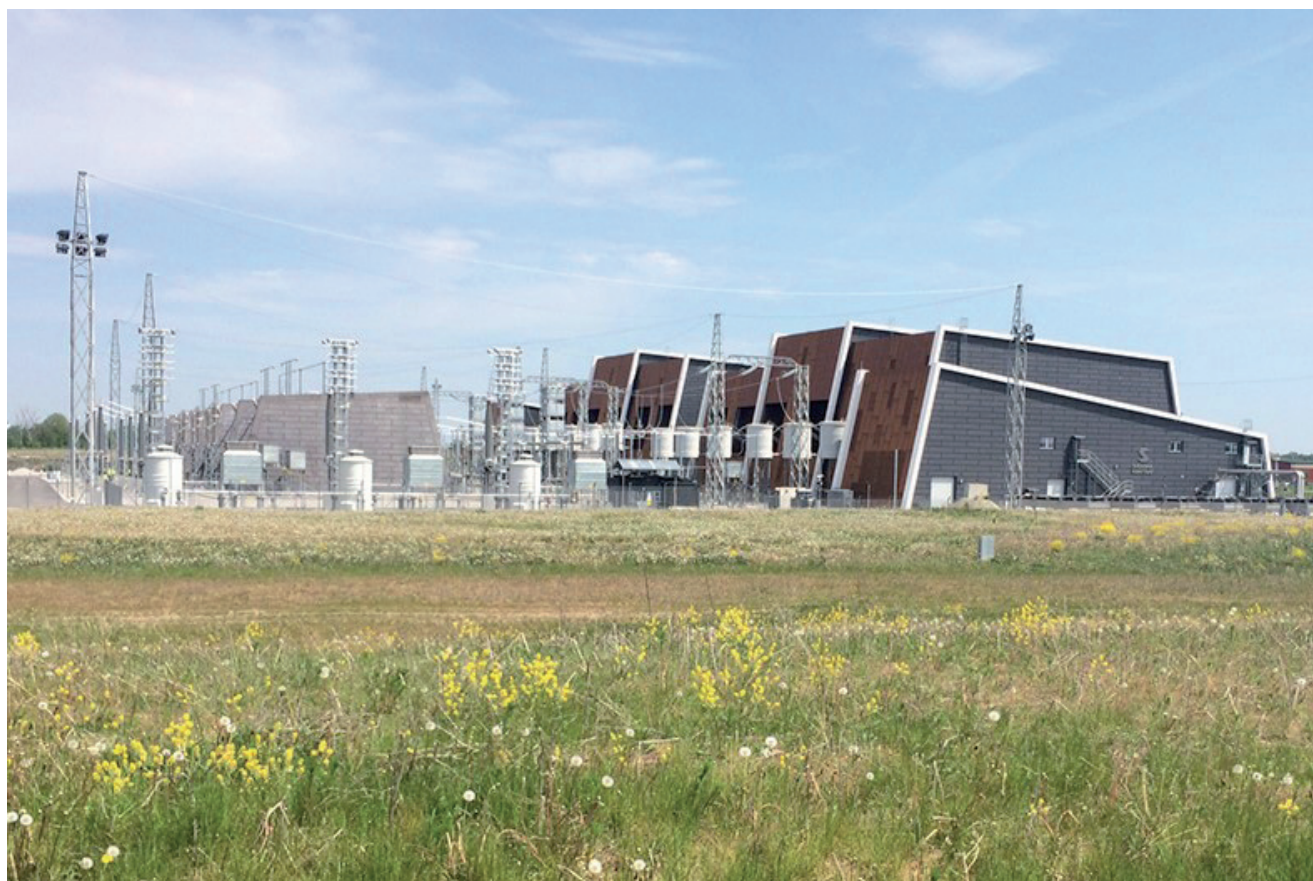
Figur 3.2 Stationsområdet i Hurva med två omriktare och tillhörande växelströmsställverk.
