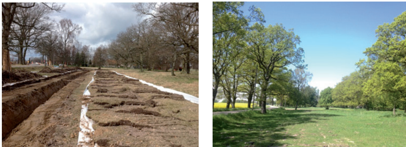
Figur 4.7 Kabelstråk under anläggningsfasen (t.v.) samt ca 2 år efter kabelinstallation (t.h.).
