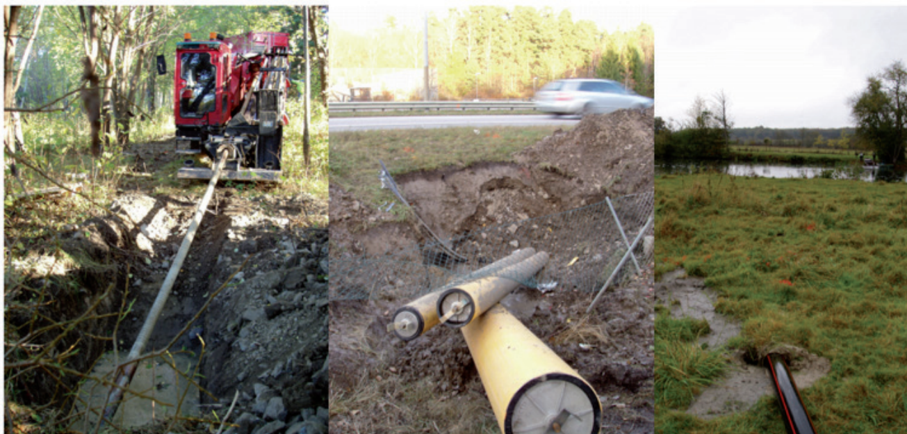
Figur 4.11 Principfigurer visande styrd borrning i olika miljöer.
