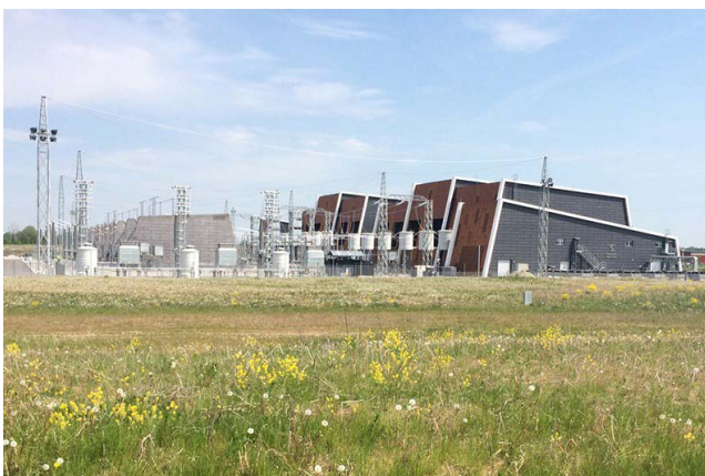
Figur 4.3 Omriktarstationen i Hurva med två omriktare och tillhörande växelströmsställverk.
