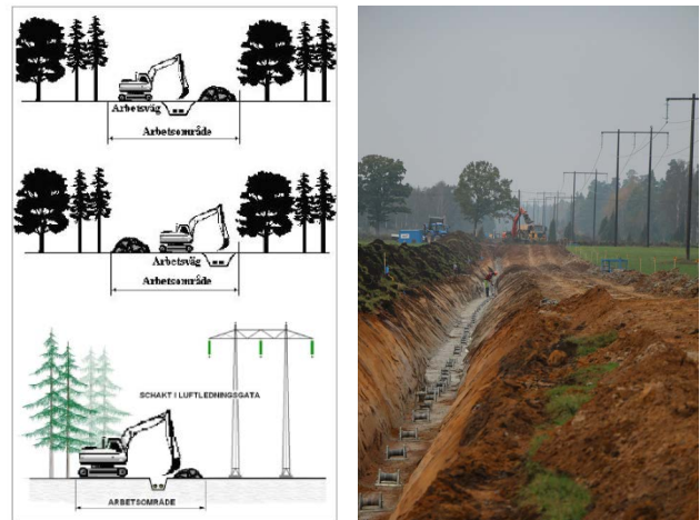
Figur 5.4 Arbetsområde (t.v.). Kabeldikesschakt (t.h.).
