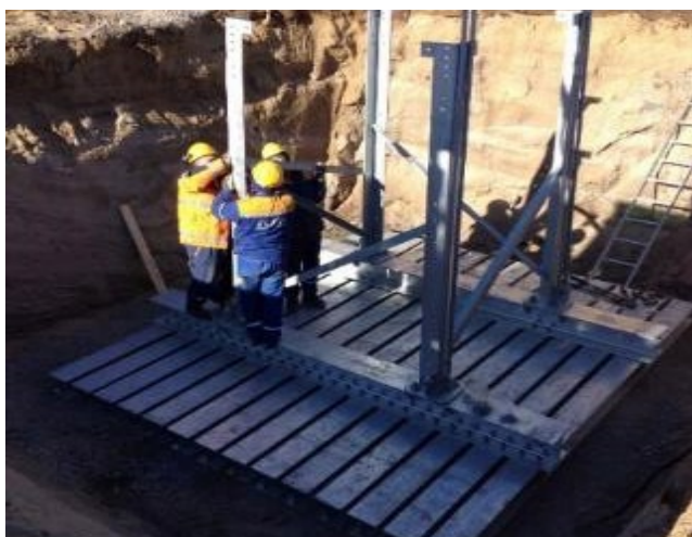
Figur 11. Foton som utvisar olika fundamentstyper, till vänster ett jordfundament med stålbalk och stålslipers och till höger ett bergfundament.
