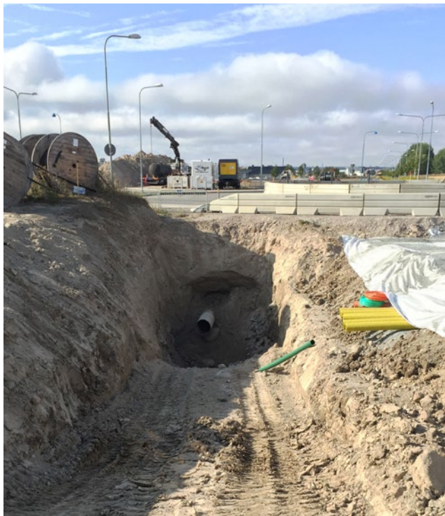
Figur 19. Bergborrning av markkabel.
