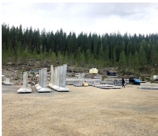
Figur 12. Exempel på prefabricerade fundament för A-stolpe till vänster (används i skogsmark) och för B-stolpe till höger (används i åkermark).
