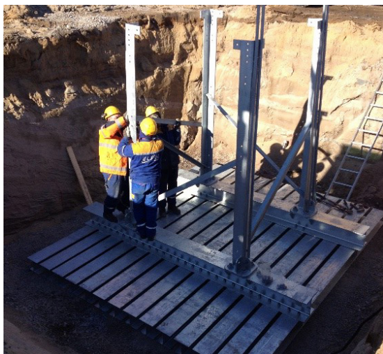
Figur 11. Visar olika fundamentstyper, till vänster ett jordfundament med stålbeak och stålslipens och till höger ett bergfundament.
