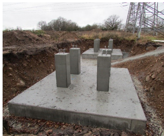
Figur 12. Exempel på prefabricerade fundament för A-stolpe till vänster (används i skogsmark) och för B-stolpe till höger (används i åkermark).
