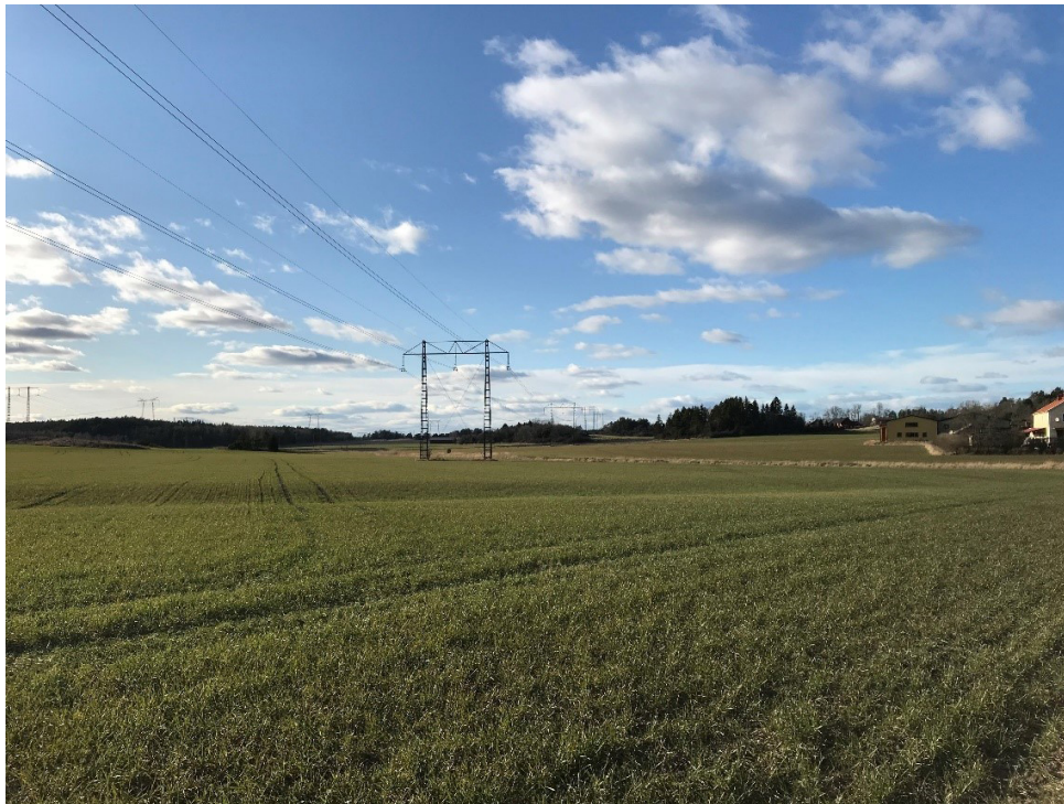
Figur 19. Boendemiljöer längs befintlig sträckning vid Bälsunda, ledningen som syns mitt i bilden ska ersättas med den nya 400 kV-ledningen.
