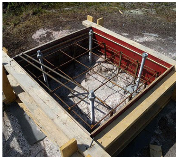
Figur 11. Visar olika fundamentstyper, till vänster ett jordfundament med stålbeak och stålslipens och till höger ett bergfundament.
