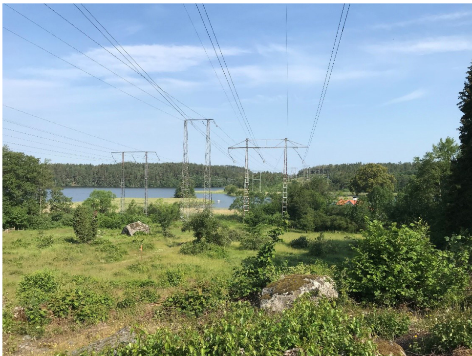
Figur 16. Foto med de befintliga ledningarna, i riktning norrut vid Roparudden. Rivningar av de äldre ledningarna kommer att göras både före, under och efter att den nya ledningen byggts och tagits i drift. KL12 S3-4 till vänster och RL6 S6 till höger i bilden. Ledningen i mitten är en 70 kV-ledning som ingår i regionnätet (i nuläget blir den kvar).
