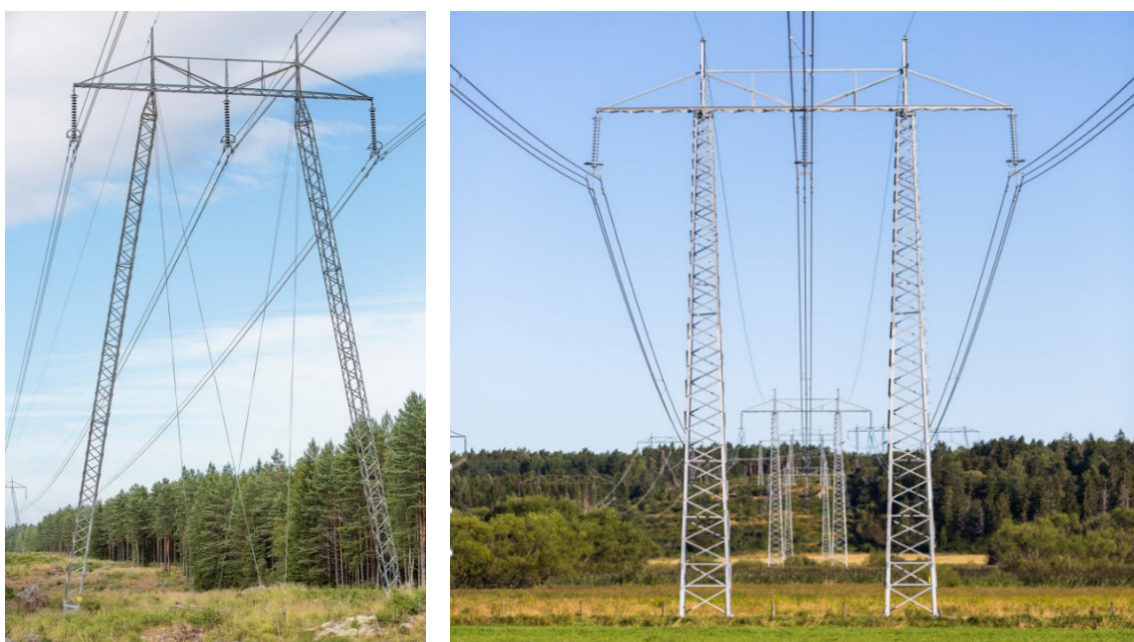
Figur 8. Exempel på stolpar: stagad A-stolpe (till vänster) och ostagad B-stolpe (till höger).
