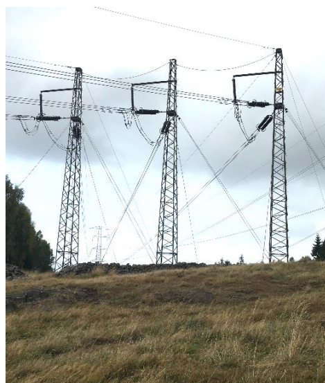
Figur 9. Exempel på vinkelstolpar, på toppen en stubbe (används endast vid stora vinklar) och ner traditionell vinkelstolpe.
