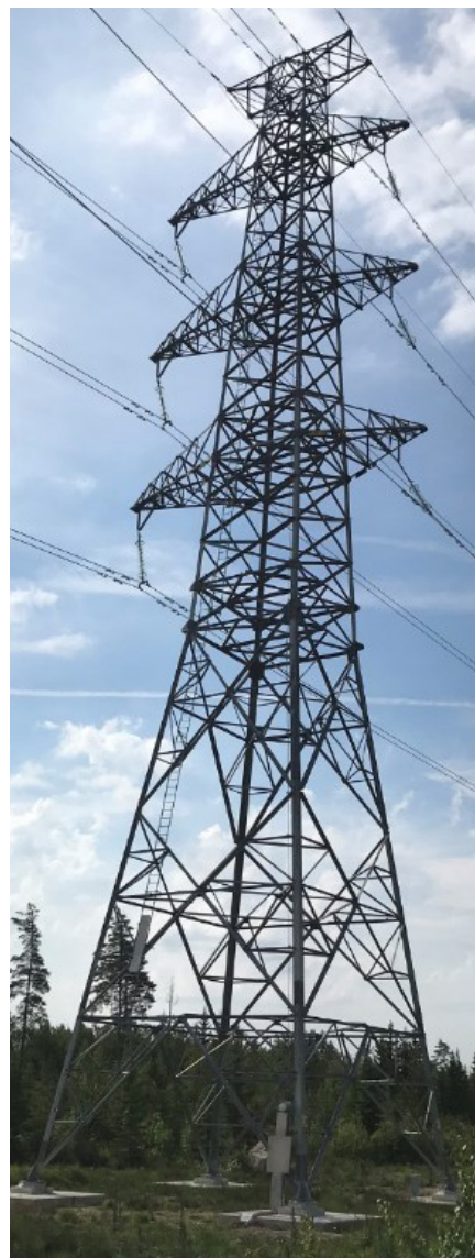
Figur 10. Exempel på sambyggd julgran i stål med två ledningar i samma stolpe.
