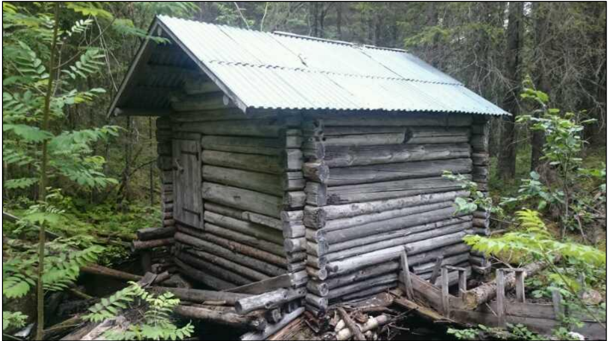
Figur 8. Exempel på hur de kvarnar i som funnits i Sågbäcken kan ha sett ut. Den är placerad på fyra större jordfasta block, vilket är det enda som återstår om träkonstruktionen försvinner. Ingen dammkonstruktion finns, utan vattnet leds in i kvarnen via en ränna utlagd i bäckfåran, synlig i bildens nedre högra kant. Kvarnen på bilden står på ursprunglig plats i Svartbäcken norr om Klista, vid utloppet i Fjällsjöälven, utanför utredningsområdet. Foto: Ola Nilsson 2015.
