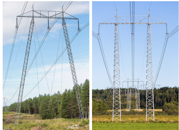
Figur 11. Stolptyper aktuella för planerad 400 kV-ledning. Till vänster: en stagad portalstolpe 400 kV typ A som huvudsakligen används i skogsmark. Till höger: ostagad portalstolpe 400 kV typ B som huvudsakligen används i jordbruksmark.
