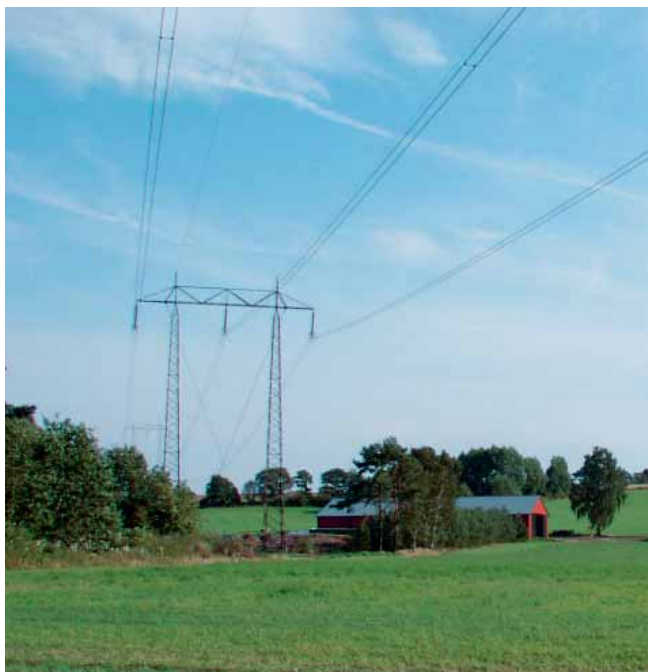
Foto befintlig portalstolpe.
