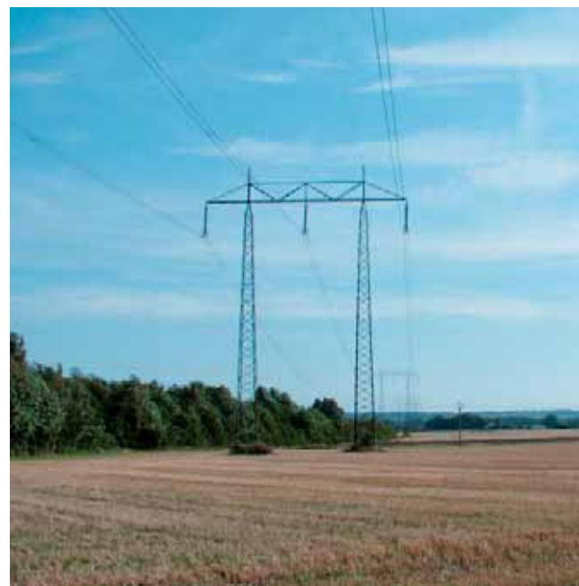
Befintlig portalstolpe för 400 kV ledning.
