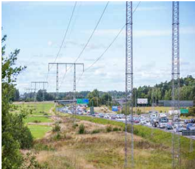
Figur 24. Exempel på befintlig luftledning med portalstolpar längs med E4:an.
