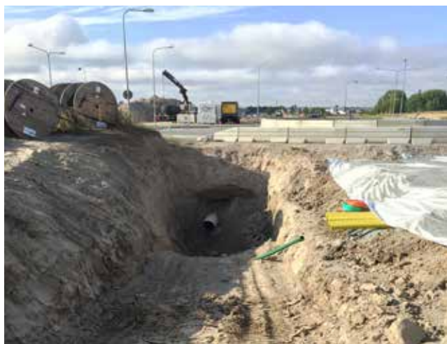
Figur 12. Bergborrning av markkabel.
