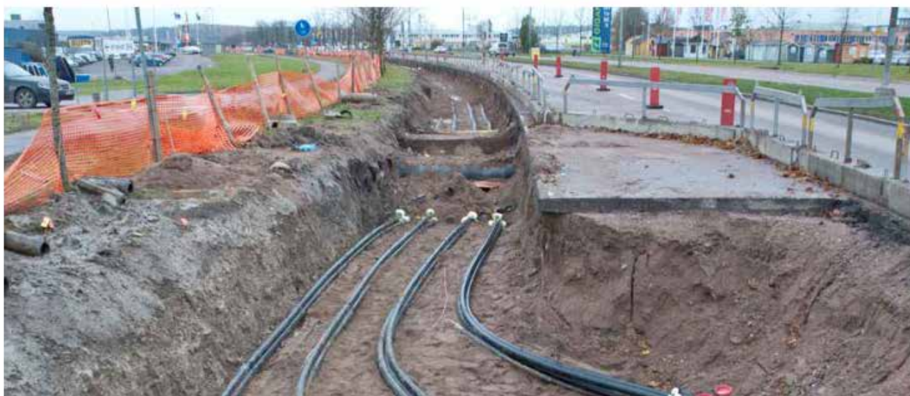
Figur 9. Exempel på markkabelschakt i tätortsnära miljö.
