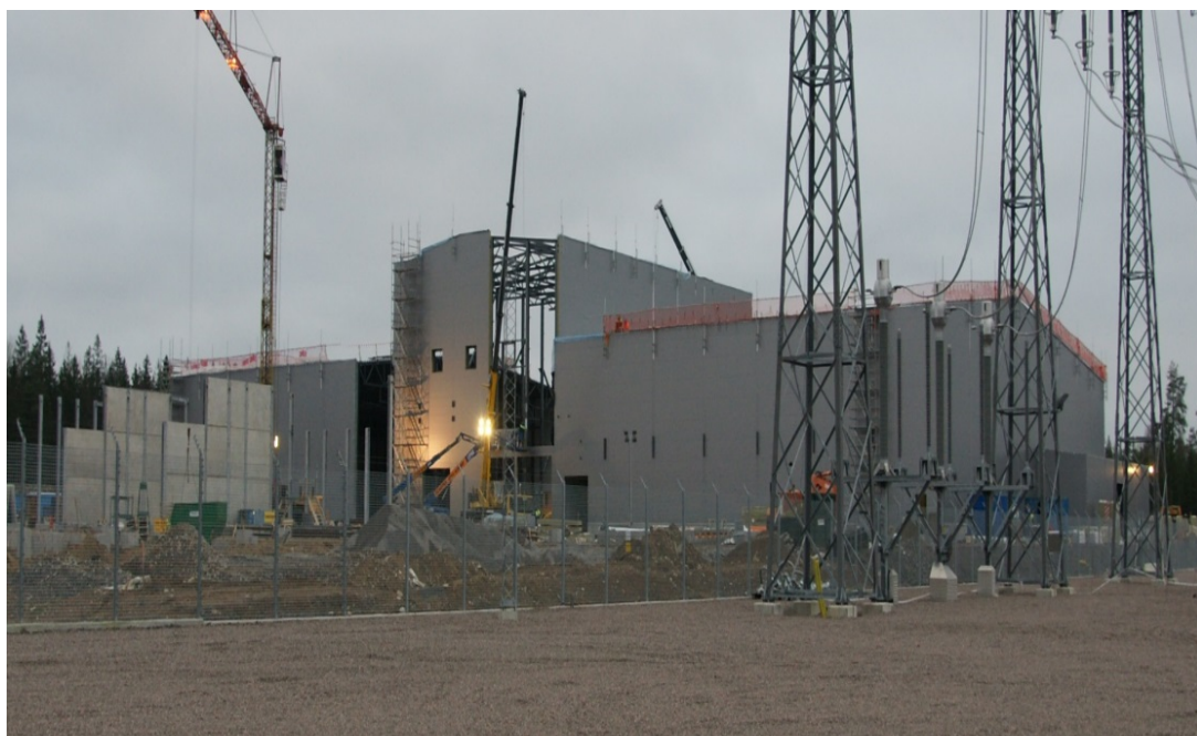
Bild 3.1. Omriktarstation för NordBalt under byggnad i Nybro.
