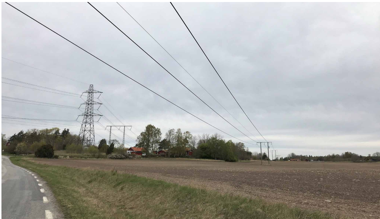
Figur 6. Vy mot norr från Brobyvägen. Svenska kraftnäts befintliga ledningar till vänster i bild och Vattenfalls ledning till höger. Området ligger inom riksintresse för kulturmiljövård, Odensala – Husby Arlinghundra (AB 67).
