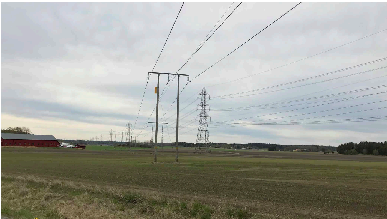
Figur 10. Vattenfalls befintliga ledning (t.v.) intill Svenska kraftnäts tre befintliga ledningar (en sambyggd i julgransstolpe) i höjd med i Slåsta där utredningskorridoren planeras att ansluta till tidigare utbyggnadsförslag. Befintliga kraftledningar är tydligt exponerade och dominerande i det flacka jordbrukslandskapet. Foto tagit i sydlig riktning.
