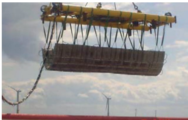
Figur 2.27 Utplacering av betongmatta.
