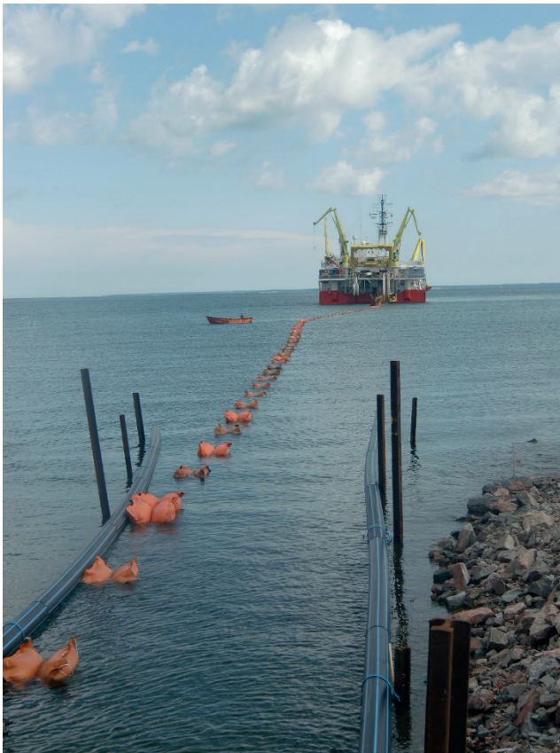
Figur 2.24 Exempel på kustnära kabelförläggning.
