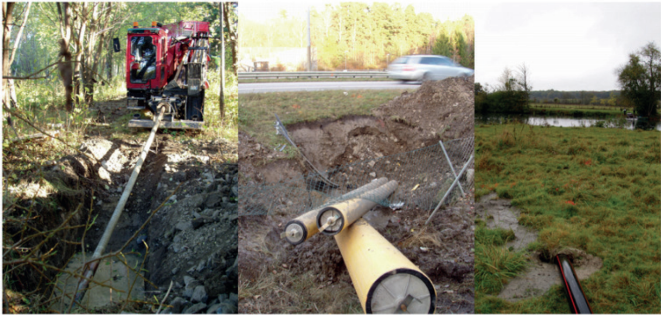
Figur 2.13 Principfigurer visande styrd borrhning i olika miljöer.
