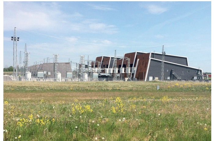
Figur 3.1 Stationsområdet i Hurva med omriktarstation och tillhörande växelströmsställverk.
