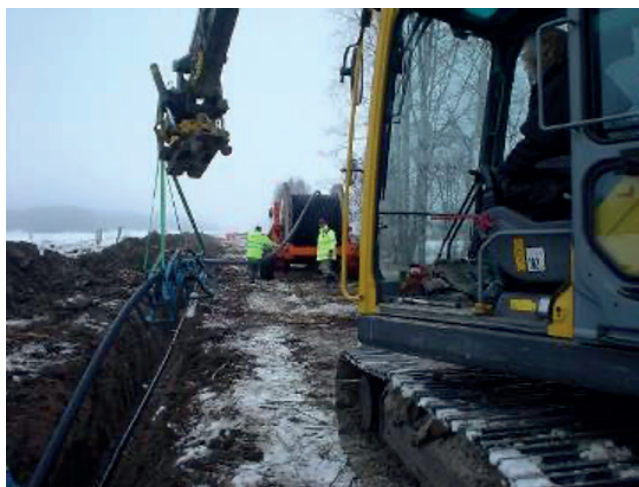
Figur 2.8 Kabelförläggning från trumvagn.
