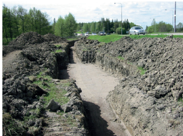
Figur 2.14 Skarvgrop för högspänningskablar.
