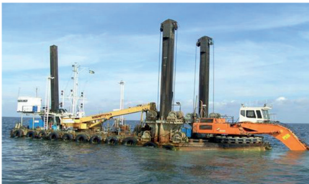
Figur 2.25 Exempel på grävmaskin på en pråm.
