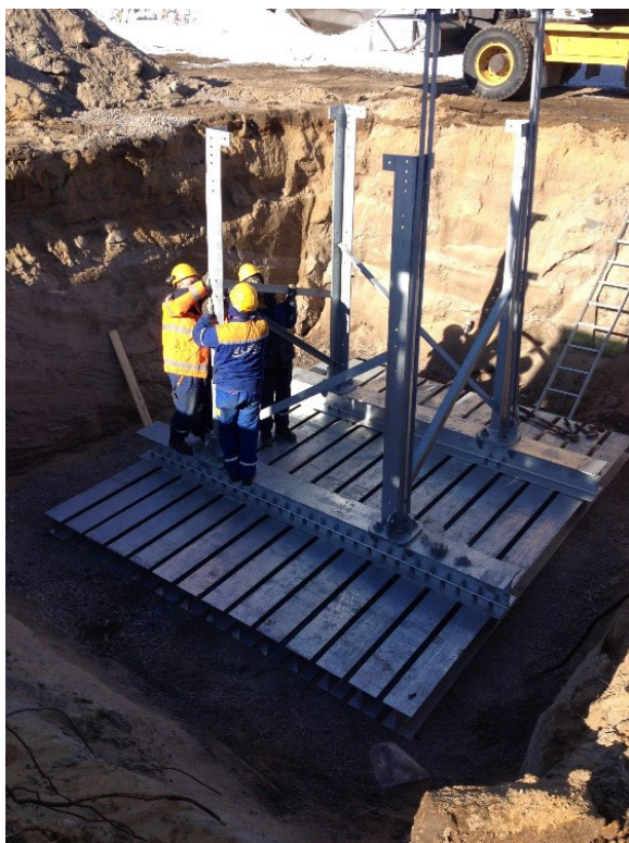
Figur 17. Exempel på olika fundamentstyper, till vänster ett jordfundament med stålbeak och stålslipers och ovan till höger en form för betonggjutning till bergfundament. Underst till höger visas armeringsarbeten för en betongplatta till en stolpe av större typ.
