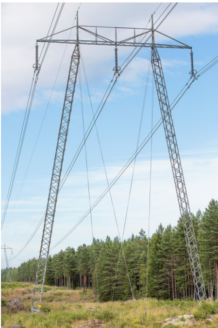
Figur 12. Exempel på stolpar. Stagad A-stolpe (till vänster). Ostagad B-stolpe (till höger).
