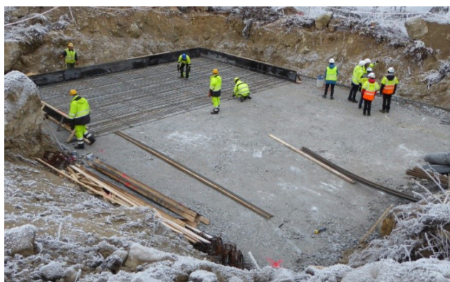
Figur 17. Exempel på olika fundamentstyper, till vänster ett jordfundament med stålbeak och stålslipers och ovan till höger en form för betonggjutning till bergfundament. Underst till höger visas armeringsarbeten för en betongplatta till en stolpe av större typ.
