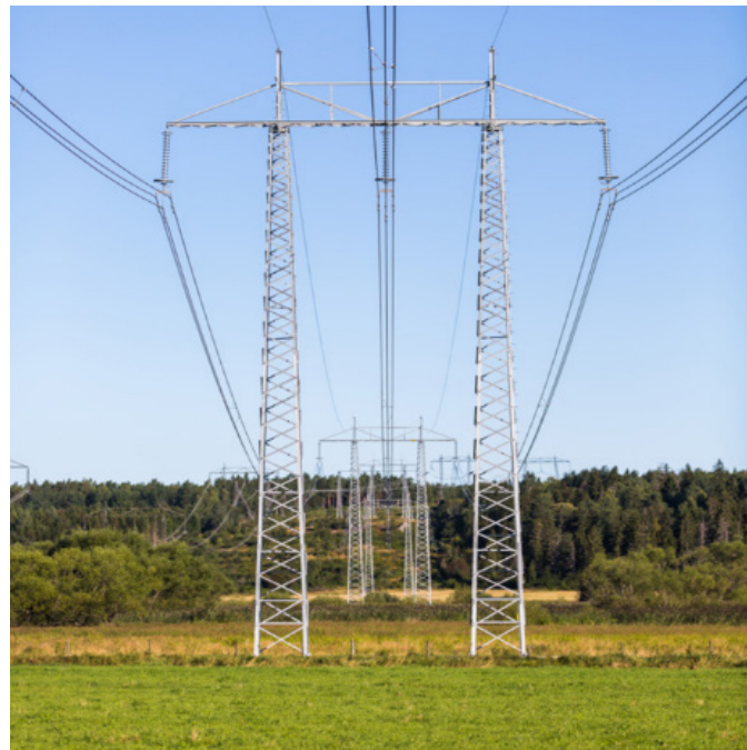
Figur 12. Exempel på stolpar. Stagad A-stolpe (till vänster). Ostagad B-stolpe (till höger).
