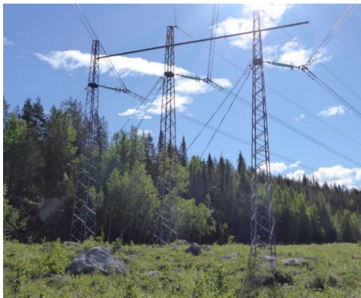
Figur 13. Exempel på vinkelstolpar, till vänster en stubbe för mycket stora vinklar (cirka 100 grader) och till höger en vinkelstolpe för måttliga vinklar (cirka 20 grader).
