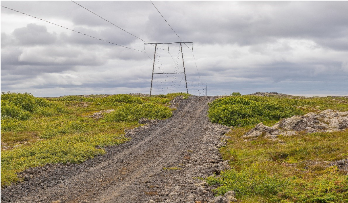
Figur 9. Exempel på stolptyp som skulle kunna bli aktuell i projektet. Bilden är tagen på en kraftledning på Island som tillhör nätbolaget Landsnet.
