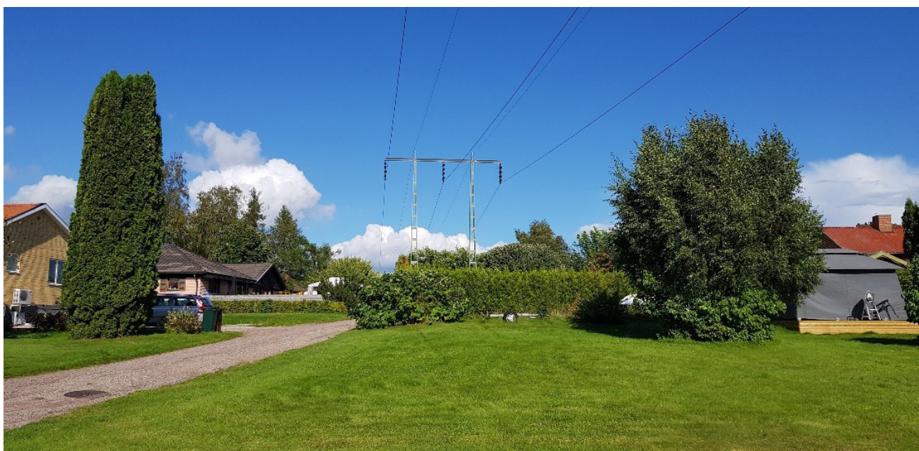
Figur 4. Befintlig 220 kV-ledning mellan Avesta och Horndal, sett mot norr ifrån Älvbro.
