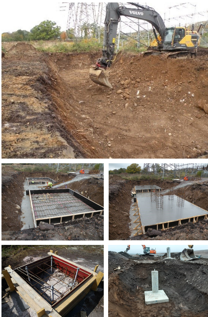
Figur 12. Exempelbilder från byggnation av kraftledning. Överst: Schaktning för jordfundament, Mitten: Platsgjutning av jordfundament. Längst ner till vänster: Form för bergfundament, Längst ner till höger: Prefabricerat jordfundament.
