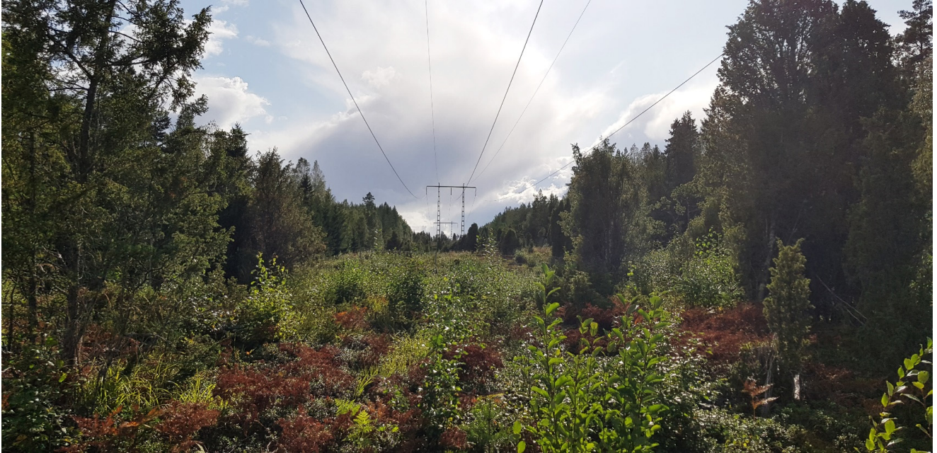
Figur 5. Befintlig 220 kV-ledning mellan Avesta och Horndal, sett mot norr ifrån söder om Avesta Visentpark.
