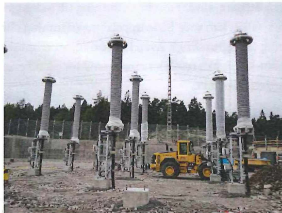
Figur 2 Kabelavslut för 400 kV växelströmsledningen Fjätören – Anneberg terminalplats Fjätören. Dimensionerna är ca 67 x 45 m 2 (från Eniro Kartor). Tomtarean uppgår till knappt 13 000 m 2 .
