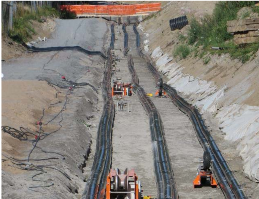
Figur 3.4. Exempel på markkabelschakt.
