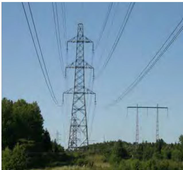
Figur 15. Illustration av julgansstolpe i stål bredvid en portalstolpe t.h.
