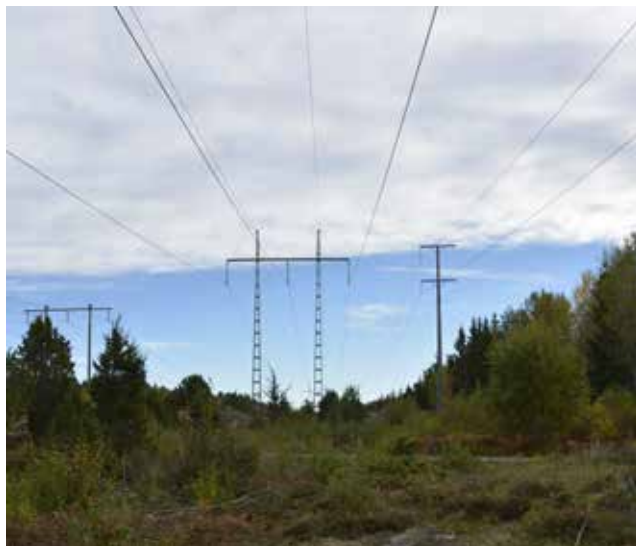
Figur 32. Befintlig ledningsgata öster om Järvafältets naturreservat. Vy mot sydost.
