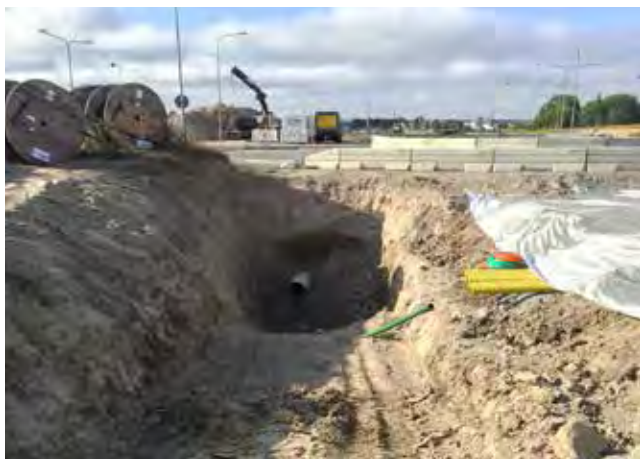
Figur 20. Bergborrning av markkabel.
