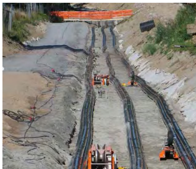
Figur 18. Exempel på markkabelschakt.
