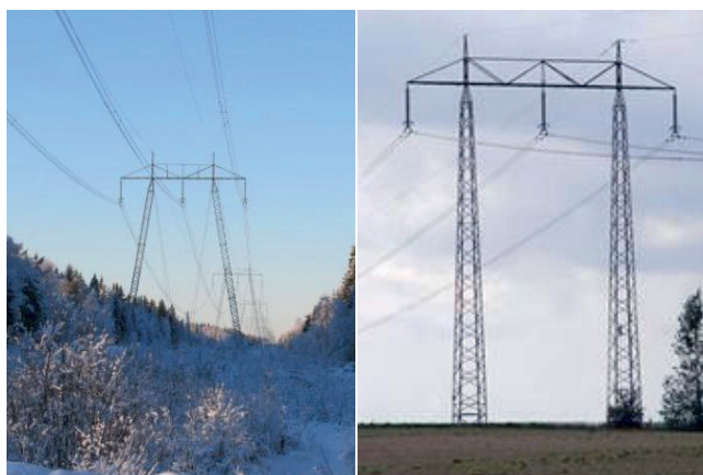
Figur 16. Exempel på stolpar. Till vänster, A-stolpe, avstånd mellan ytterfaser ca 18 meter. Till höger, B-stolpe, avstånd mellan ytterfaser ca 22 meter.
