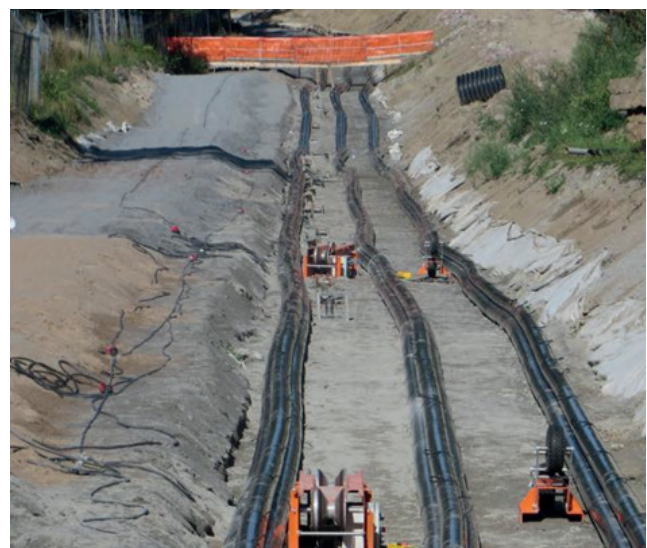
Figur 22. Exempel på markkabelschakt.
