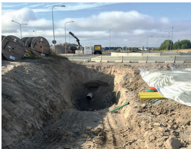
Figur 24. Bergboring av markkabel.
