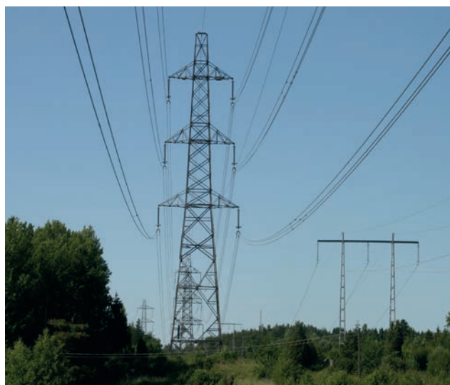
Figur 18. Exempel på julgransstolpe, till vänster i bilden. Stolptypen kan bland annat användas för sambyggnad av två olika ledningar med olika spänning.
