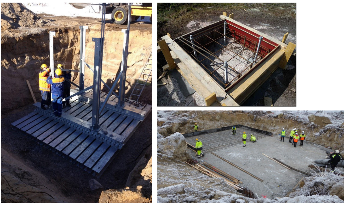
Figur 17. Exempel på olika fundamentstyper, till vänster ett jordfundament med stålslipers och ovan till höger en form för betonggjutning till bergfundament. Underst till höger visas armeringsarbeten för en betongplatta till en stolpe av större typ.
