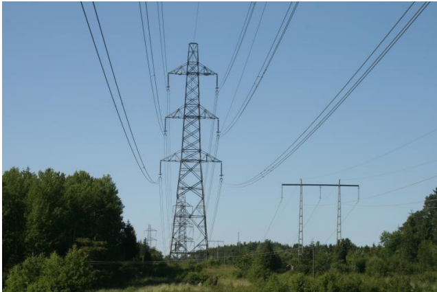
Figur 14. Foto på julgransstolpe i stål bredvid en portalstolpe till höger.
