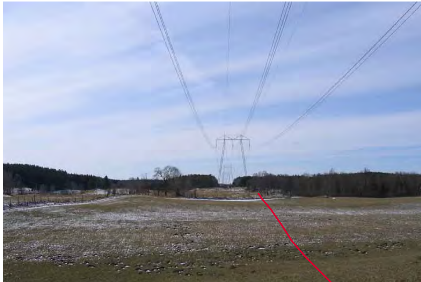
Figur 12.27 Den nya ledningen planeras som markkabel i befintlig ledningsgata vid Fundersed, vy mot norr.
