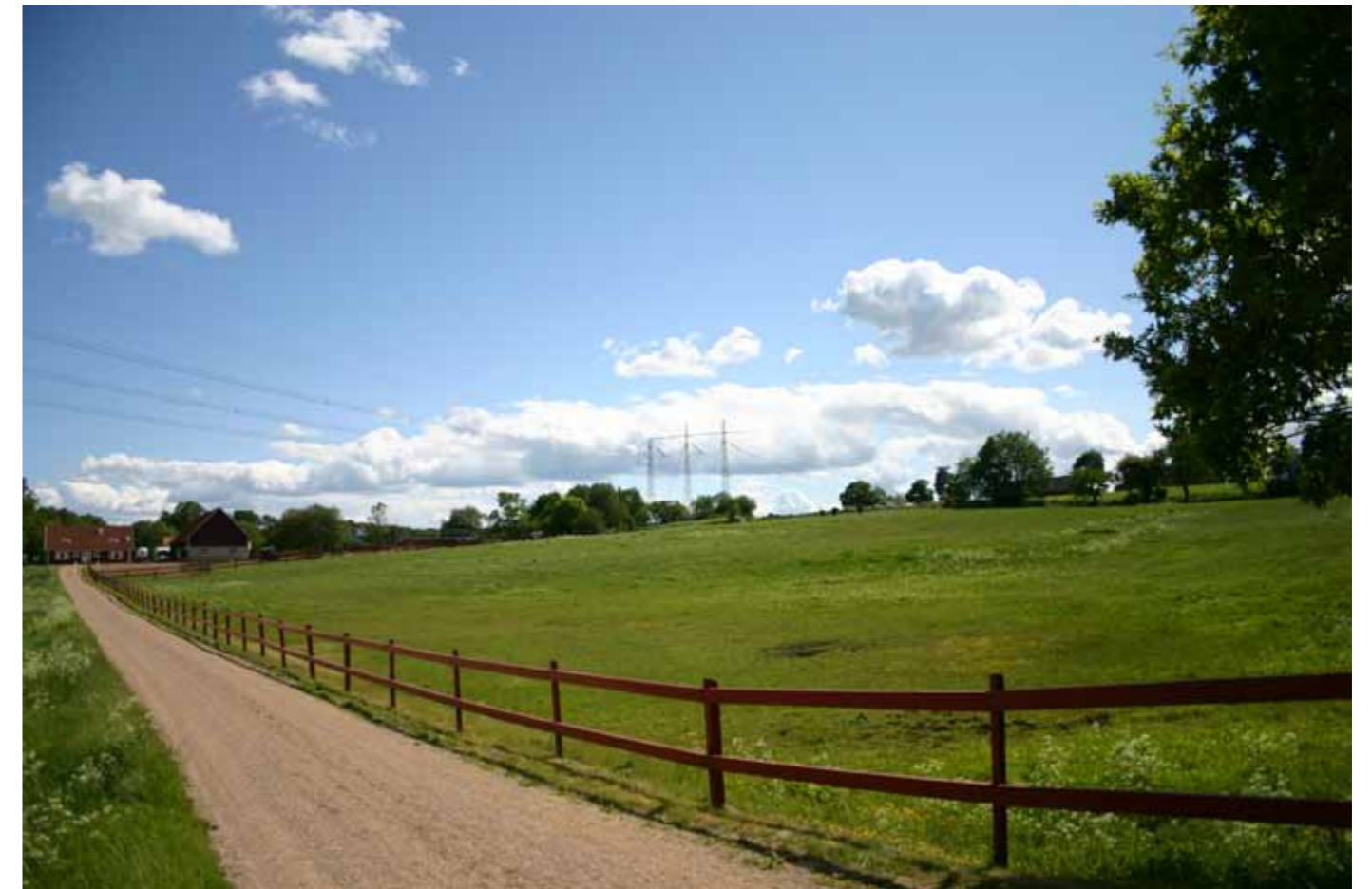
Figur 12.28 Befintlig ledningsgata vid Fundersed.
