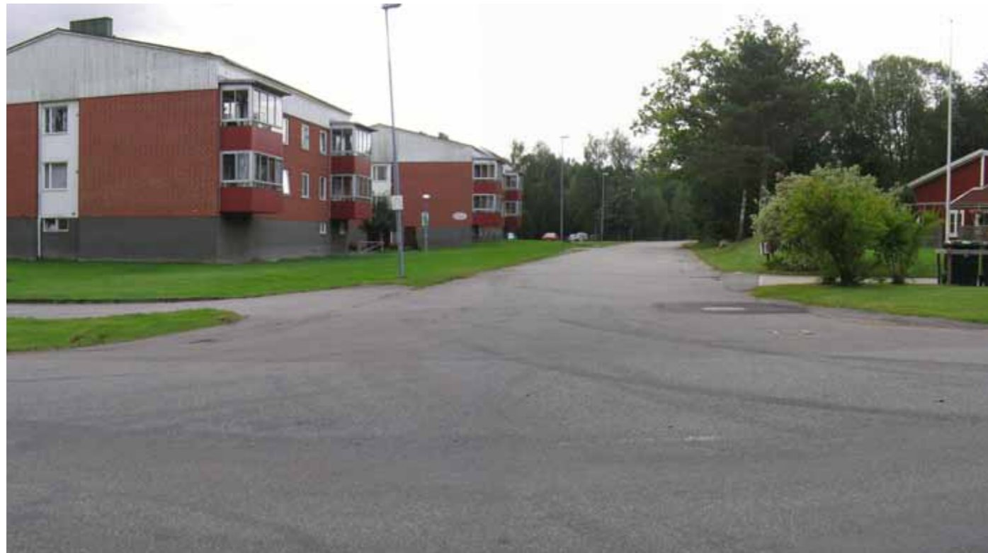
Figur 12.10 Befintlig bebyggelse vid fastigheterna Vittsjö 118:1, 2:95, 88:4 och 2:98 (Pilvägen). Kabeln placeras inom gatemark eller i grönytan till vänster i bild.
