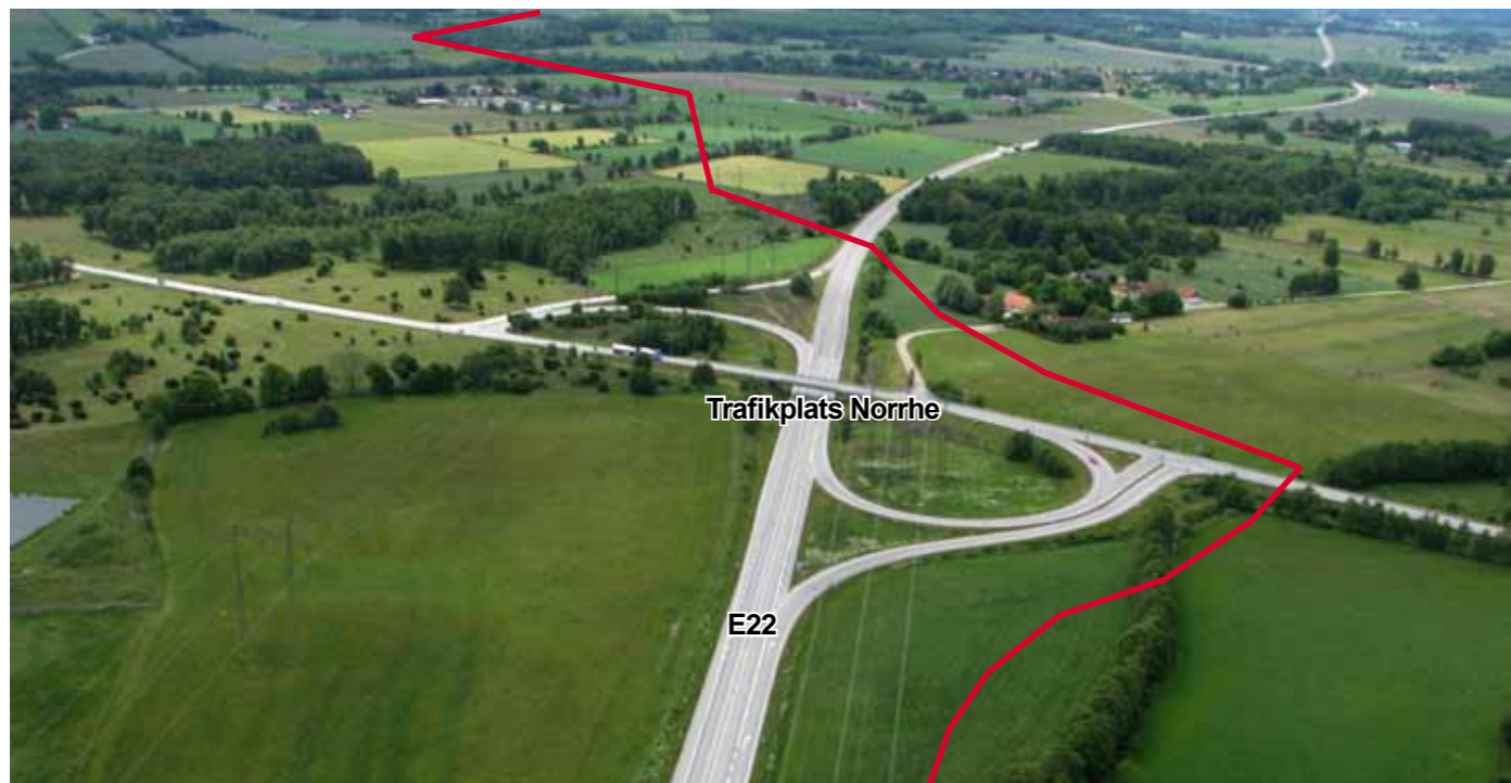
Figur 12.7 Vy motsyd över trafikplats Norrhe (korsning E22/Väg13) utanför Hörby.
