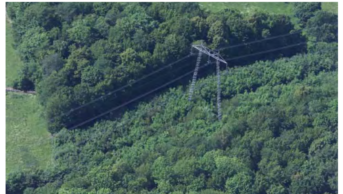
Figur 12.20 Befintlig kraftledningsgata tangerar ädellövskogen NBM12 i bildens nederkant. Vy mot nordväst.
