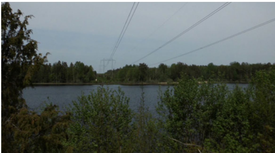
Figur 7.1 Befintlig 400 kV-ledning passerar över sjön Stor-Brå.
