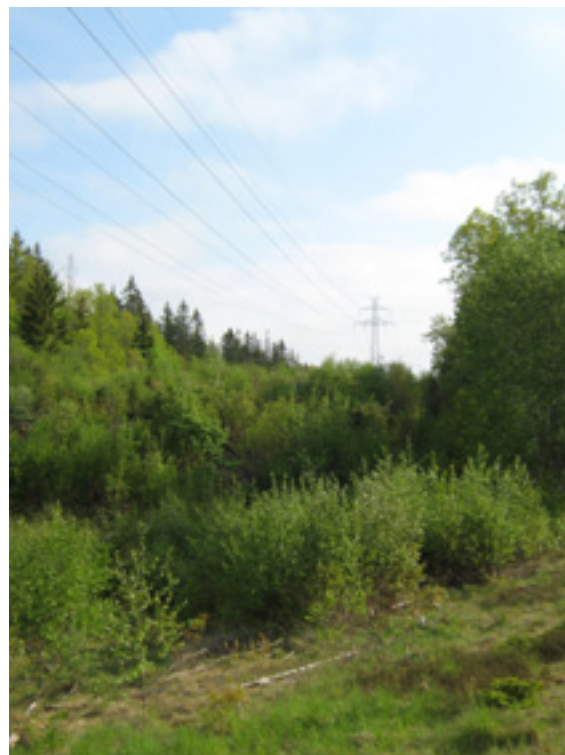
Figur 7.3 Befintlig 130 kV-ledning passerar Natura 2000-område vid Figeholm.
