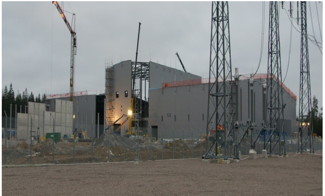
Bild 2. Omriktarstation för NordBalt under byggnad i Nybro.
