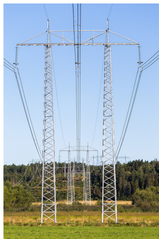
Figur 11. Exempel på stolpar. Stagad A-stolpe (till vänster). Ostagad B-stolpe (till höger).
