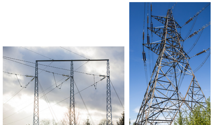
Figur 12. Exempel på vinkelstolpar, till vänster en Stubbe för stora vinklar och till höger en vinkelstolpe för måttliga vinklar.
