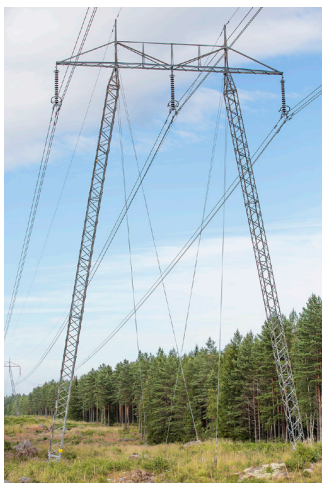
Figur 11. Exempel på stolpar. Stagad A-stolpe (till vänster). Ostagad B-stolpe (till höger).
