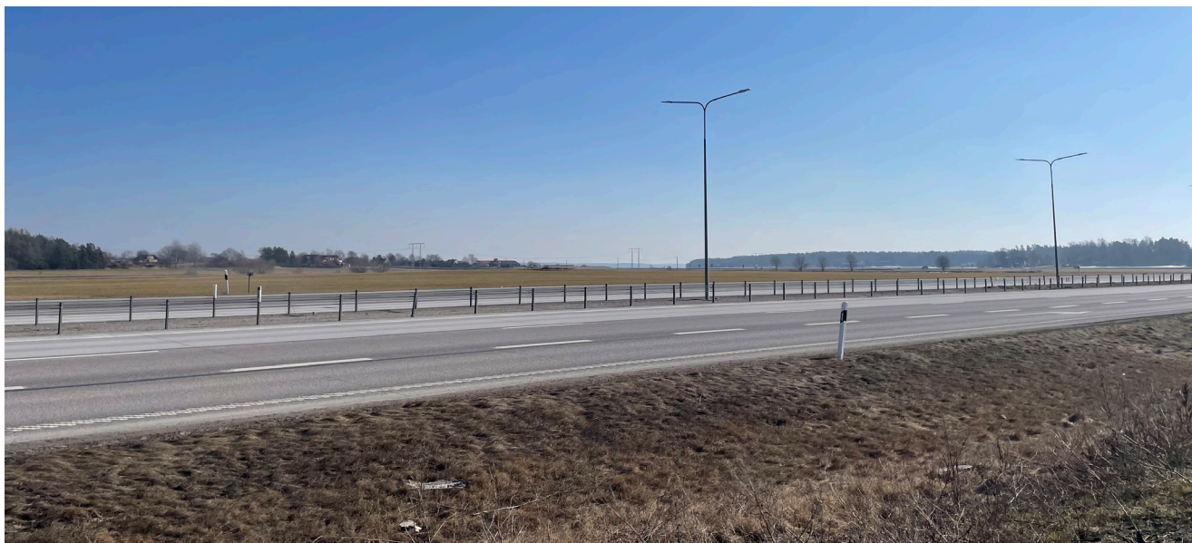
Figur 16. Vy mot sydöst över befintlig och planerad ledningsgata längs E4:an vid Östra Fyrislund.
