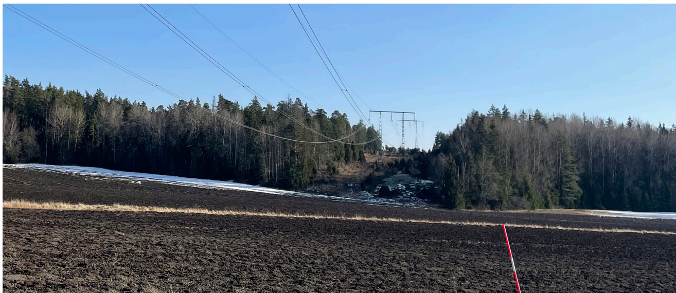
Figur 15. Befintlig ledningsgata genom skogsmark söder om Danmark.
