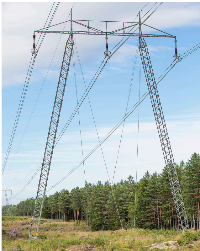
Figur 3. Exempel på portalstolpar. Stagad A-stolpe (till vänster). Ostagad B-stolpe (till höger).
