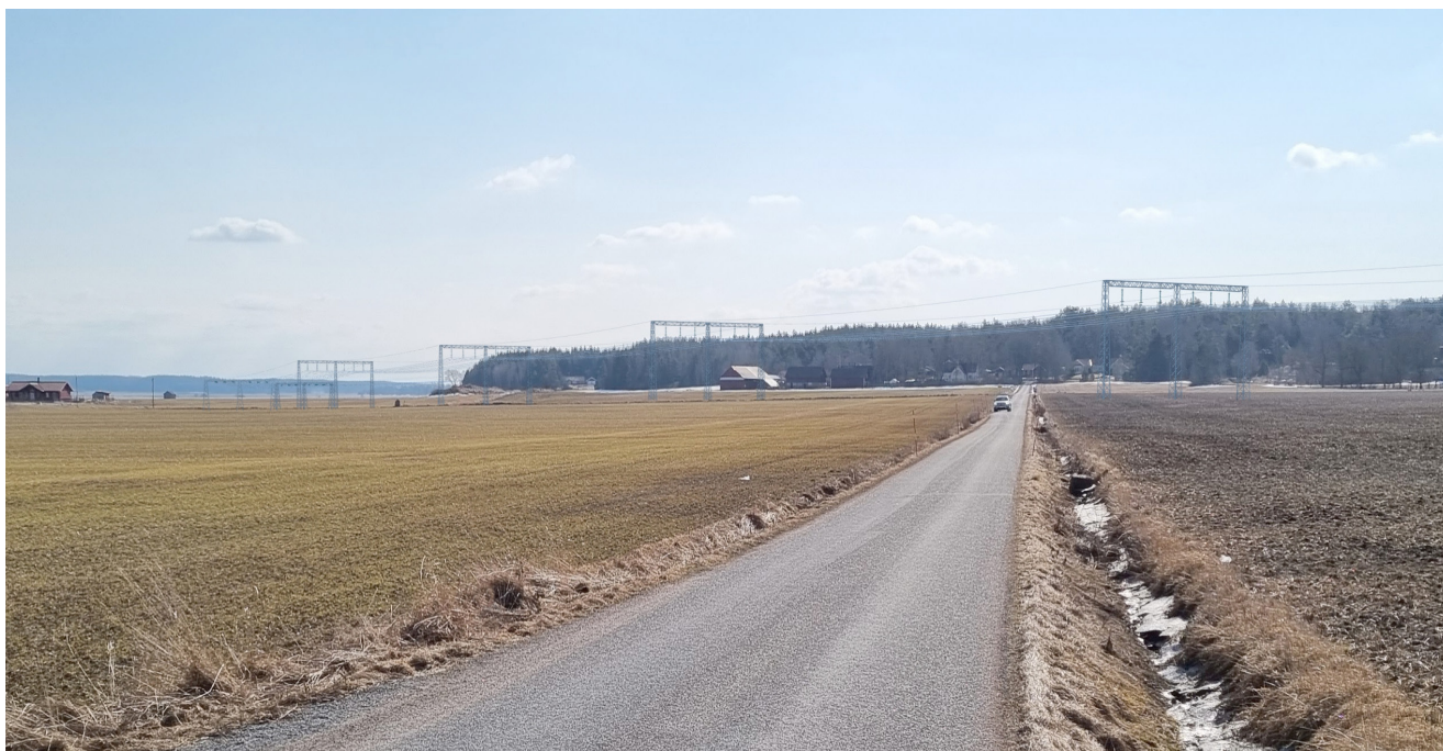
Figur 12. Fotomontage av planerade sambyggda lågbyggda portalstolpar för 2x400 kV över jordbruksmark norr om Danmark. Vy mot söder.
