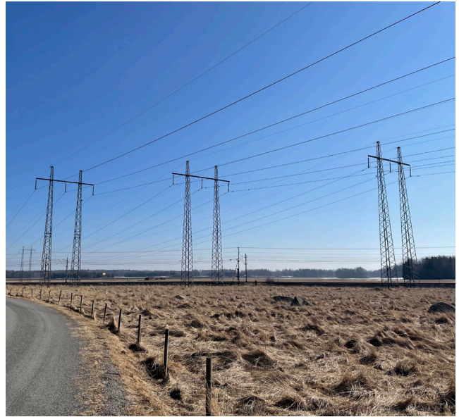
Figur 19. Utformning och foto på befintliga 220 kV portalstolpar (RL8 S6, RL11 S1, KL42 S1) öster om station Bredåker.
