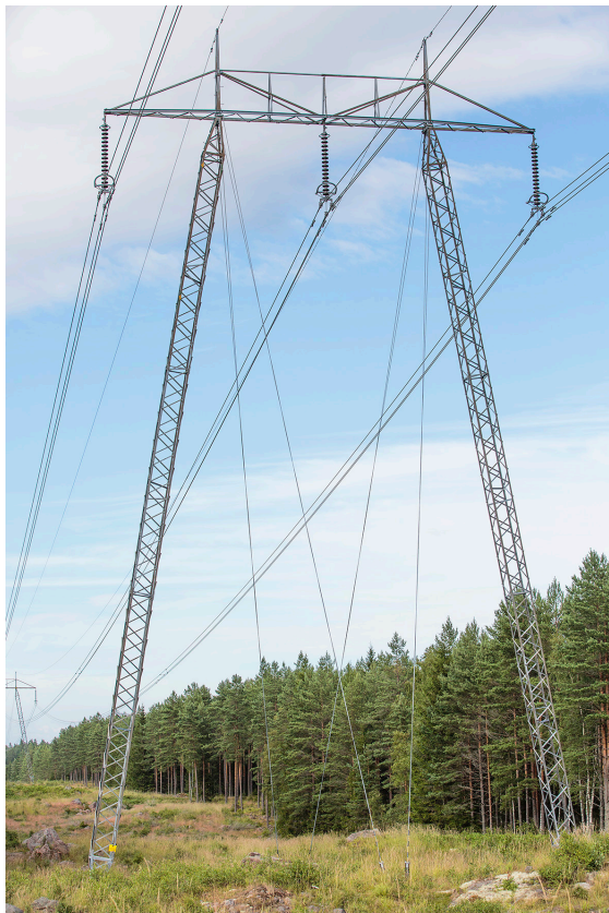
Figur 7. Exempel på portalstolpar. Stagad A-stolpe till vänster och ostagad B-stolpe till höger.
