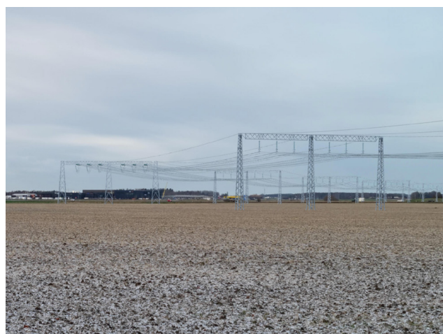
Figur 11. Fotomontage över sambyggd lågbyggd portalstolpe för 2x400 kV.
