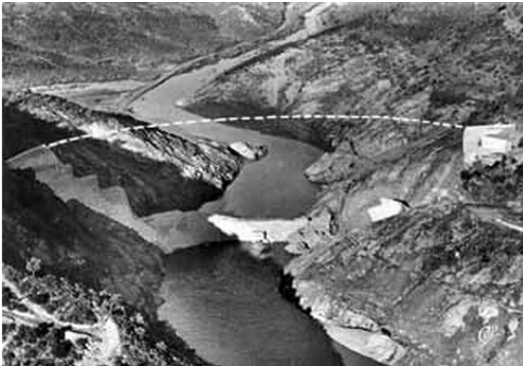
Figur 5. Resterna av Malpassedammen i Frankrike som gick till brott fem år efter dess färdigställande, 1959, med följd att 423 personer förolyckades. Orsaken till dammhaveriet tros ha varit en kombination av höga grundvattenttryck och förkastningar i undergrunden. I princip hela dammkroppen bröts loss från dammläget.
