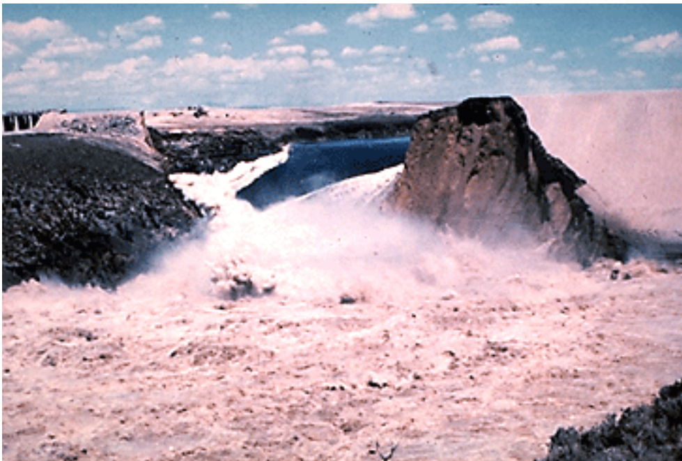
Figur 6. Fotografi taget då Teton-dammen rasade 1976. Dammen rasade under första uppfyllnadsfasen. Effekterna av dammhaveriet utreddes aldrig officiellt men elva människor miste livet. Orsaken har inte gått att fastställa men läckage genom grundläggningen och/eller tät kärnan är troliga orsaker.
