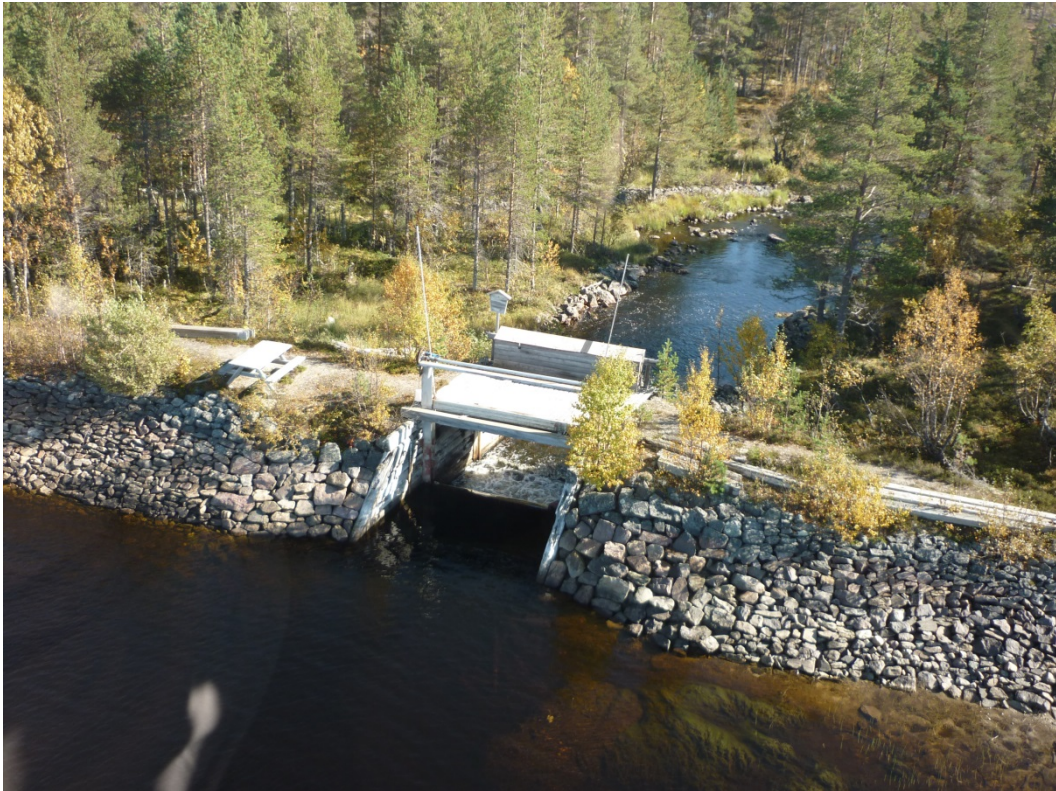
Figur 8. Exempel på en sammansatt damm, där utskovsdelens pelare består av knuttimrade träkistor fyllda av sten, med anslutande fyllningsdammar på båda sidor. Om en av utskovspelarna havererar kommer utskovet att öppnas för vattengenomströmning, men det kan även antas att den anslutande fyllningsdammen som exponeras kommer att erodera så att brottöppningen vidgas väsentligt.
