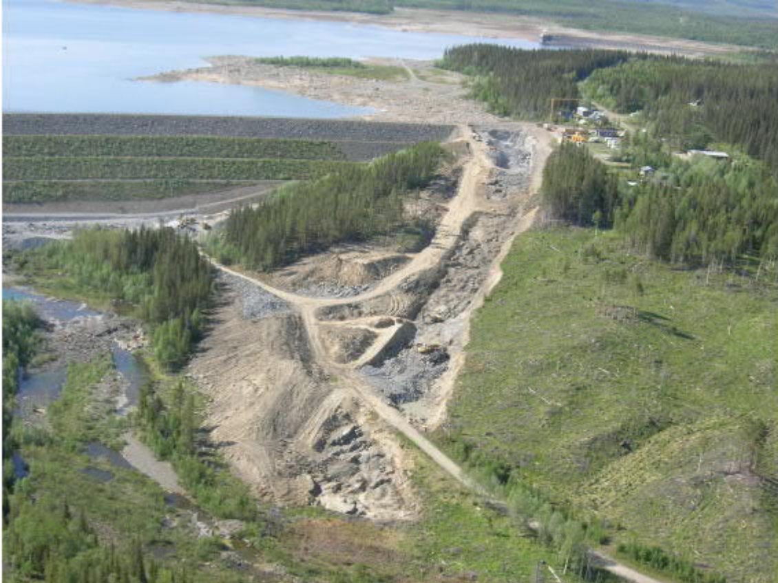
Figur 7. Ombyggnadsarbeten för att förse Håckrendammen med ett nytt ytutskov. (Foto: Vattenregleringsföretagen, 2006)
