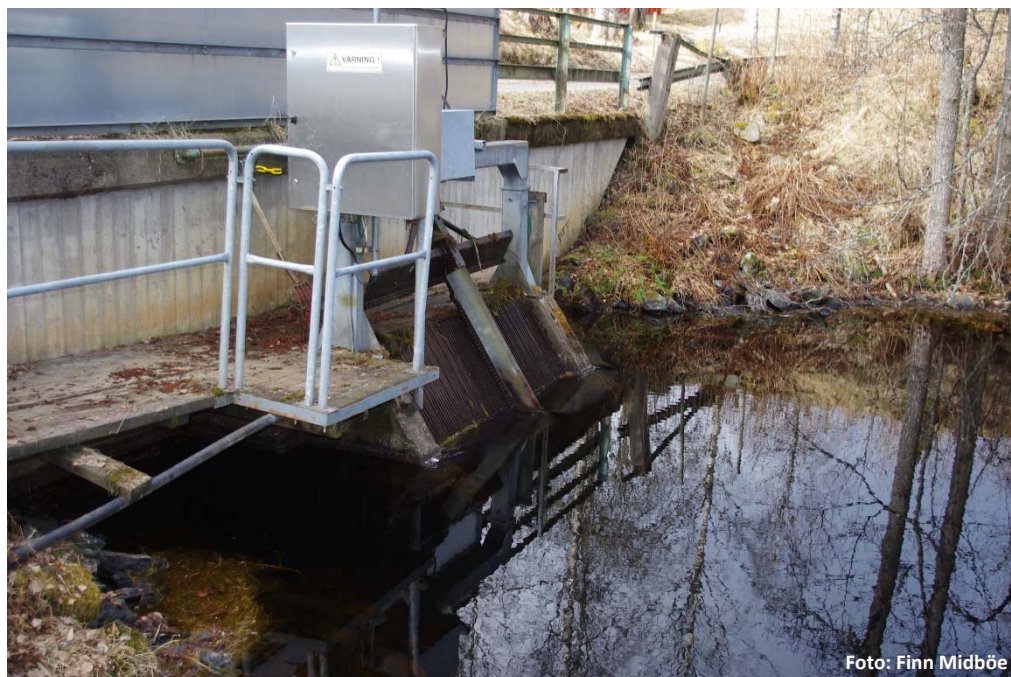
Figur 2. Kanalintaget som begränsar utflödet från kanalen i händelse av dammhaveri.
