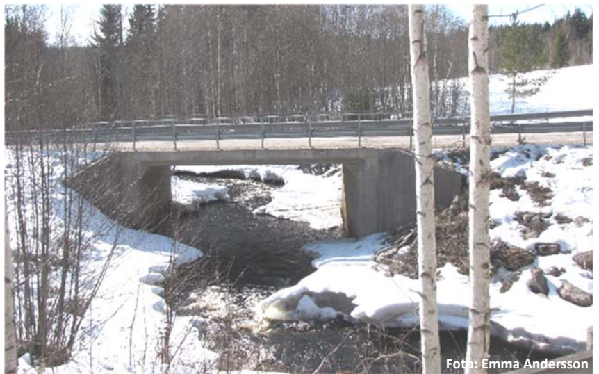
Figur 7. Bro för utgörande skadeobjekt nr 2.
