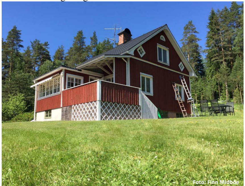
Figur 8. Bostadshus utgörande skadeobjekt nr 3.
