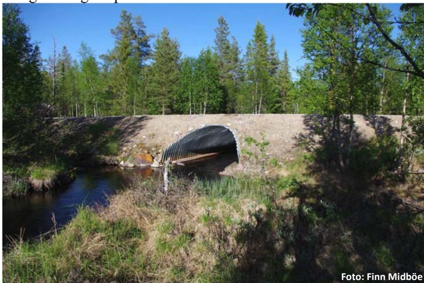
Figur 4. Väg och vägtrumma som utgör skadeobjekt nr 1.
