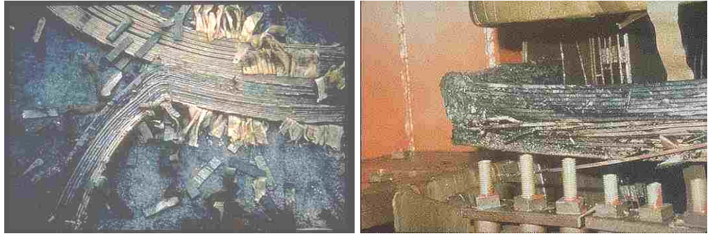
Figur 1.1: Transformatorskador som har orsakats av lokala värmehärdar. [4]
