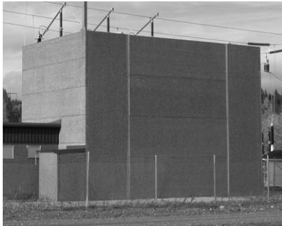
Figur 6 Exempel på demonterbar väggdel enligt ovan beskrivet utförande
